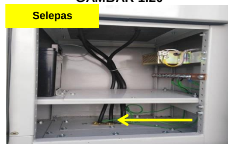
Jambatan Batang Samarahan (Papan Agihan Di Span 7 )
