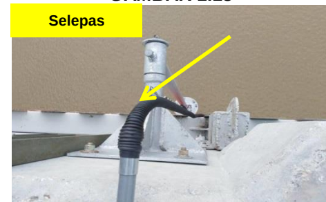
Jambatan Batang Samarahan - Konduit Boleh Lentur Telah Dipasang (02.10.2018) (Sumber: Jabatan Kerja Raya Sarawak)
