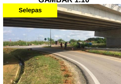
Jambatan Batang Samarahan (Bawah Jambatan) - Penanaman Spot Turfing Telah Dilaksanakan (04.10.2018) (Sumber: Jabatan Kerja Raya Sarawak)
