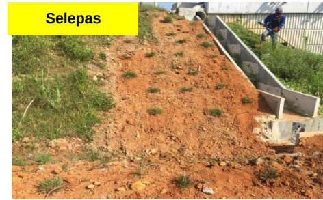
Jambatan Batang Samarahan - Cerun Ditutup dan Ditanam Rumput (04.10.2018) (Sumber: Jabatan Kerja Raya Sarawak)
