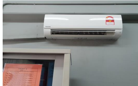
Bilik Production Executive, LRA Nyabau - Aset Tidak Dilabel (31.07.2018)
