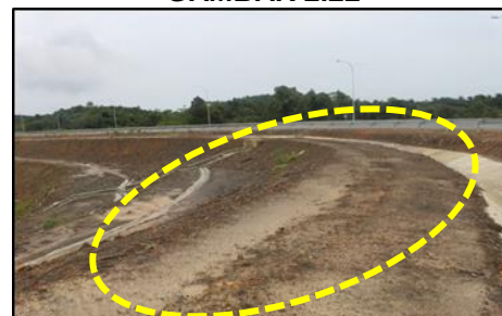
CH2500 Persimpangan Jalan C1 - Spot Turfing Tidak Ditanam di Kawasan Tanah yang Terdedah (03.10.2018)
