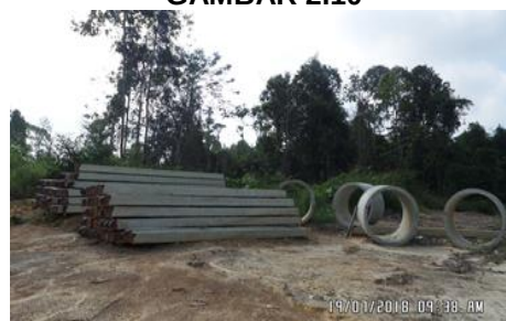
Phase 4 Stage 2 - Proposed Collector Road B2 - RC Pile dan RC Pipe Culvert yang Berada di Tapak Bina (19.07.2018)
