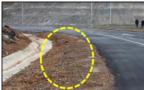
CH1475 Persimpangan Jalan B1 - Spot Turfing Tidak ditanam pada Bahu Jalan (03.10.2018)
