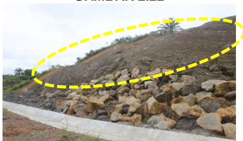
CH1475 Persimpangan Jalan B1 - Spot Turfing Tidak Ditanam pada Cerun (03.10.2018)
