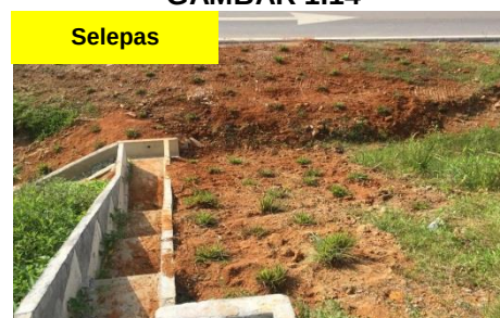
Jambatan Batang Samarahan (Bawah Jambatan) - Penanaman Spot Turfing Telah Dilaksanakan (04.10.2018) (Sumber: Jabatan Kerja Raya Sarawak)
