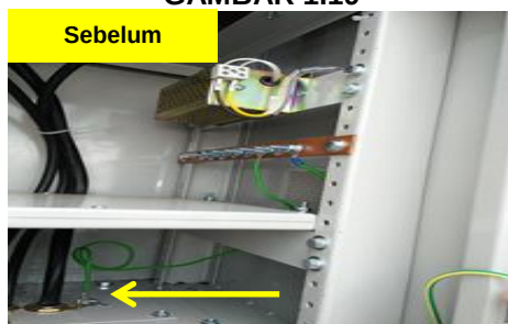
Jambatan Batang Samarahan (Papan Agihan Di Span 7 )
