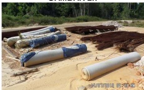
Phase 4 Stage 2 - Proposed Collector Road B2 - Geotextile dan Steel Reinforcement yang Berada di Tapak Bina (19.07.2018)
