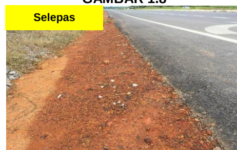
Jambatan Batang Samarahan (Road Widening To Connect Jalan Muara Tuang/Semera/Pendam Junction) - Bahu Jalan Telah Dibaiki (25.09.2018) (Sumber: Jabatan Kerja Raya Sarawak)
