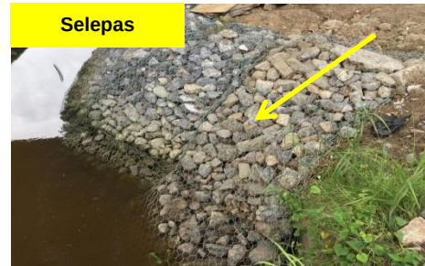
Jambatan Batang Samarahan - River Slope Protection Telah Dikemas (04.10.2018) (Sumber: Jabatan Kerja Raya Sarawak)
