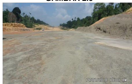
Projek Phase 4 Stage 2 - Proposed Collector Road B2 - Kerja Awal yang Telah Dilaksanakan Sebelum Kontrak Ditamatkan (19.07.2018)
