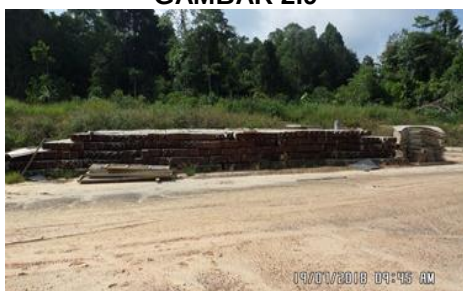
Phase 4 Stage 2 - Proposed Collector Road B2 - RC Pile yang Berada di Tapak Bina (19.07.2018)
