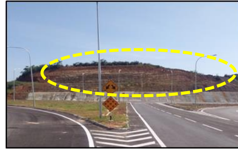
CH2500 Persimpangan Jalan C1 - Spot Turfing Tidak Ditanam di Cerun (03.10.2018)
