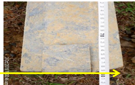
Jalan C1 - Phase 5 Stage 1 - Proposed Samalaju Boulevard Package 1 - Tiang Lampu Jalan Ditanam pada Kedalaman 800mm (03.10.2018)
