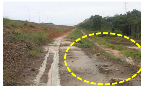
CH2500 Persimpangan Jalan C1 - Spot Turfing Tidak ditanam di Kawasan Tanah yang Terdedah (03.10.2018)
