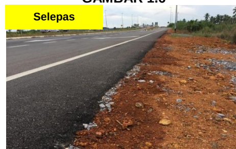
Jambatan Batang Samarahan Chainage 0-380 (Approach Road) - Bahu Jalan Telah Dibaiki (25.09.2018) (Sumber: Jabatan Kerja Raya Sarawak)
