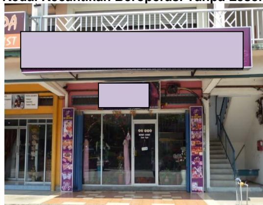
Gambar 2.2 Kedai Kecantikan Beroperasi Tanpa Lesen
