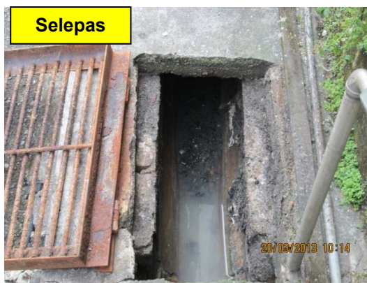
Gambar 2.6 Longkang Yang Telah Dibersihkan
