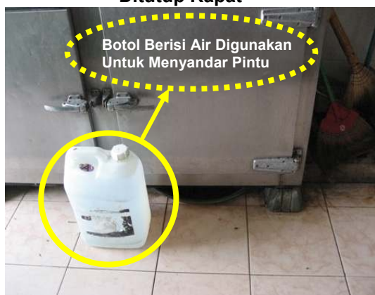
Gambar 1.3 Pintu Peti Sejuk Yang Tidak Boleh Ditutup Rapat
