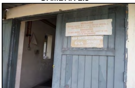
Bangunan Utara Baraj - Bilik Papan Suis Utama (16.10.2017)
