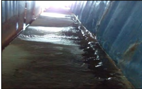
Phase 2 Package 1 Bahagian Mukah, Sarawak - Kesan Kebocoran Tangki Flokulasi (20.07.2017)
