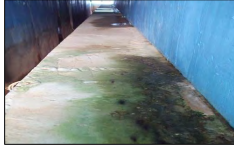
Phase 2 Package 1 Bahagian Mukah, Sarawak - Kesan Kebocoran Tangki Flokulasi (20.07.2017)
