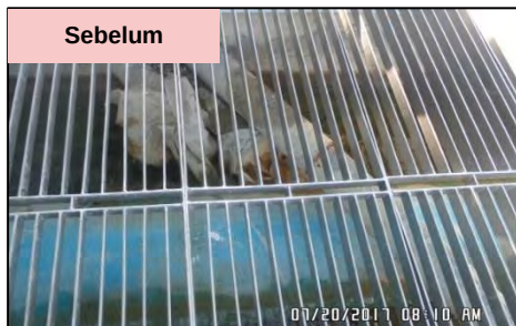
Phase 2 Package 1 Bahagian Mukah, Sarawak - Saluran Kabel Lama Tidak Dibuang (20.07.2017)
