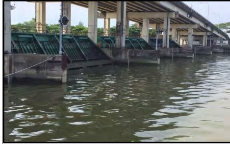
Baraj Kuching - Pintu Air Baraj Sebelum Operasi Flushing Out Dijalankan (16.10.2017)
