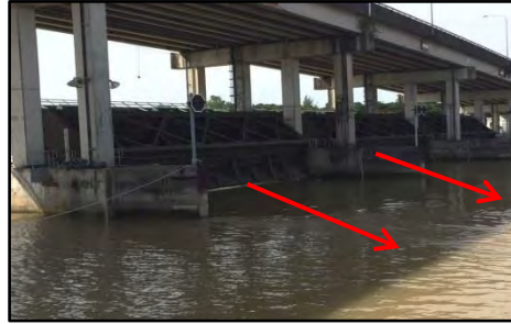
Baraj Kuching - Pintu Air Baraj yang Dibuka Menyebabkan Air Bergerak ke Hilir Baraj Dalam Operasi Flushing Out (16.10.2017)
