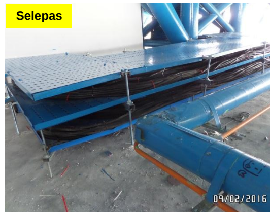
Gambar 2.4 Kabel Elektrik Untuk Lampu Limpah Telah Disusun
