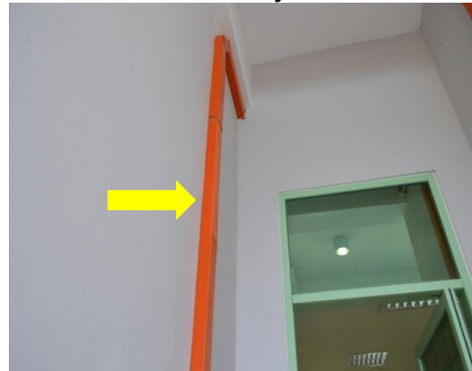
Gambar 3.2 Pemasangan Trunking Di Bilik Mesyuarat
