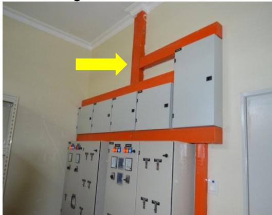
Gambar 3.1 Pemasangan Trunking Dan Papan Fius Agihan Di Bilik Elektrik
