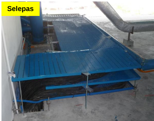
Gambar 2.3 Kabel Elektrik Untuk Lampu Limpah Telah Disusun
