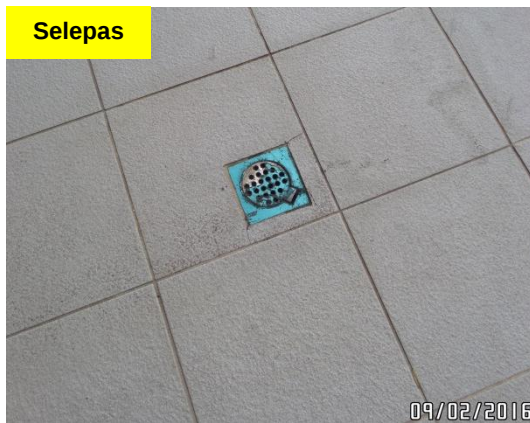
Gambar 2.19 Pemasangan Perangkap Air Telah Dibuat
