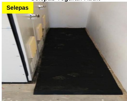
Gambar 2.6 Pelapik Getah Diletakkan Di Atas Lantai Selepas Teguran Audit
