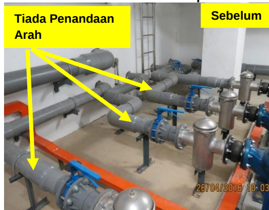
Gambar 2.11 Tiada Penandaan Arah Anak Panah Air Masuk/Keluar Pada Paip Air
