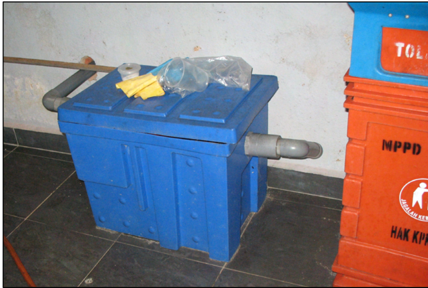
Foto 72 Kedudukan Perangkap Gris Yang Dipasang Di Gerai Perhentian Bas Port Dickson
