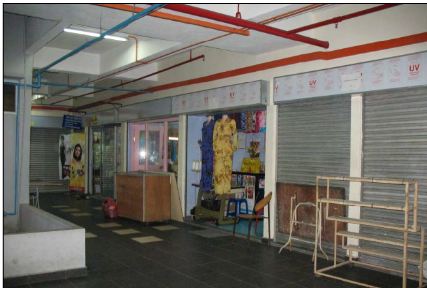
Foto 64 Gerei Majlis Di Tingkat 1 Bangunan Perhentian Bas Port Dickson
