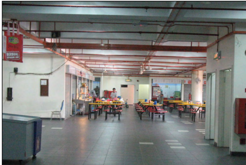
Foto 63 Gerei Majlis Di Tingkat 1 Bangunan Perhentian Bas Port Dickson
