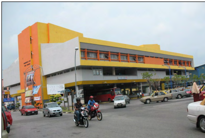
Foto 62 Gerai Majlis Di Tingkat 1 Bangunan Perhentian Bas Port Dickson
