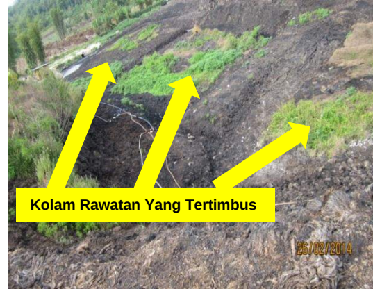
Gambar 5.3 Kawasan Kolam Rawatan Yang Tertimbus
