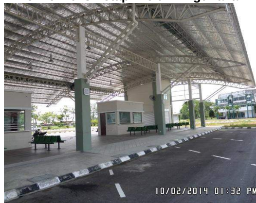
Gambar 2.8 Terminal Bas Yang Siap Dibina Pada 25 Mei 2013 Tetapi Belum Digunakan
