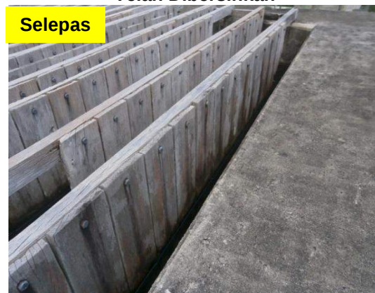
Gambar 1.10 Sesekat ( Baffles ) Di Tangki Flokulasi Telah Dibersihkan
