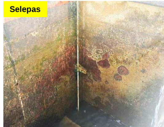
Gambar 1.8 Dinding Tangki Telah Dibersihkan
