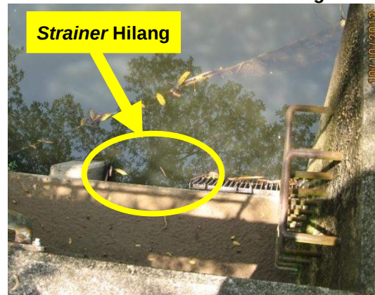
Gambar 1.4 Strainer Di Muka Sauk Hilang
