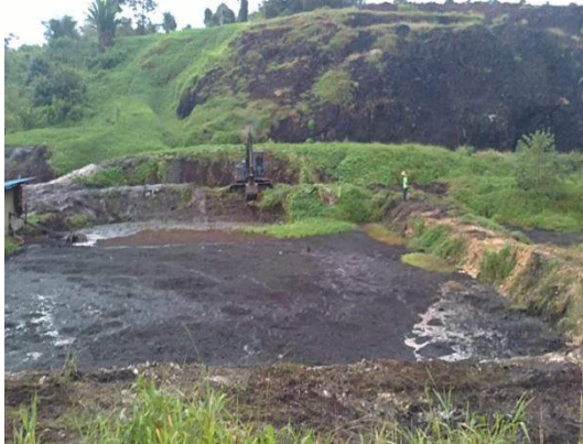
Gambar 5.2 Kolam Rawatan Sebelum Tertimbus
