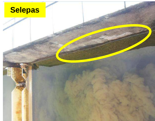
Gambar 1.6 Dinding Tangki Pemendapan Telah Dibersihkan
