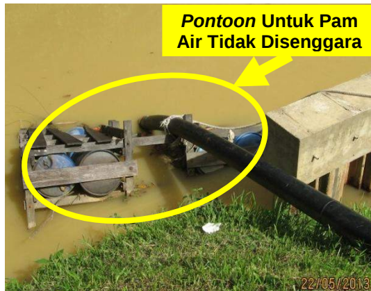
Gambar 1.3 Pontoon Untuk Pam Air Mentah
