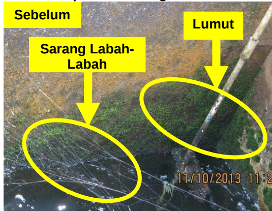
Gambar 1.7 Dinding Tangki Ditumbuhi Lumut Dan Dipenuhi Sarang Labah-Labah
