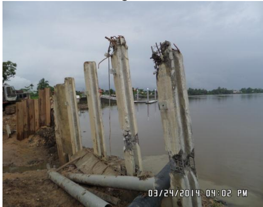
Gambar 1.4 Tiang Konkrit Bertetulang Wellguard Condong Dan Retak
