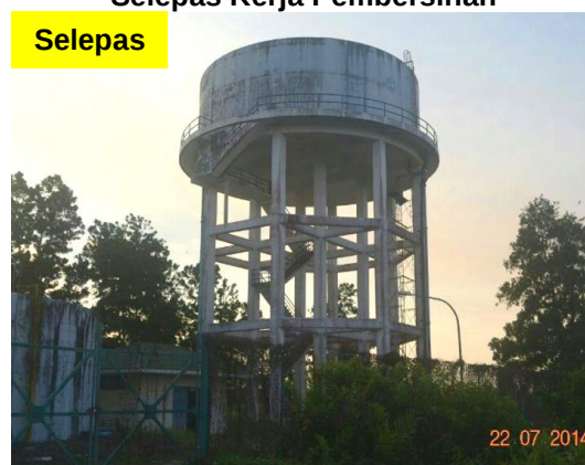
Gambar 2.16 Kawasan High Level Water Tank Selepas Kerja Pembersihan
