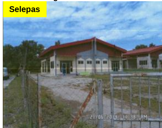
Gambar 2.9 Premis Bengkel/Kilang Yang Telah Dibersihkan
