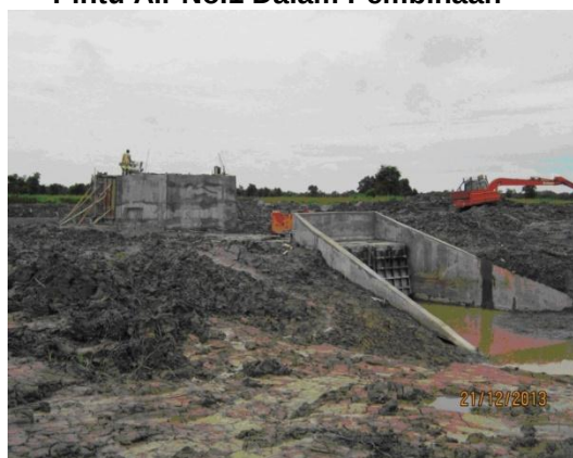
Gambar 1.19 Pintu Air No.1 Dalam Pembinaan
