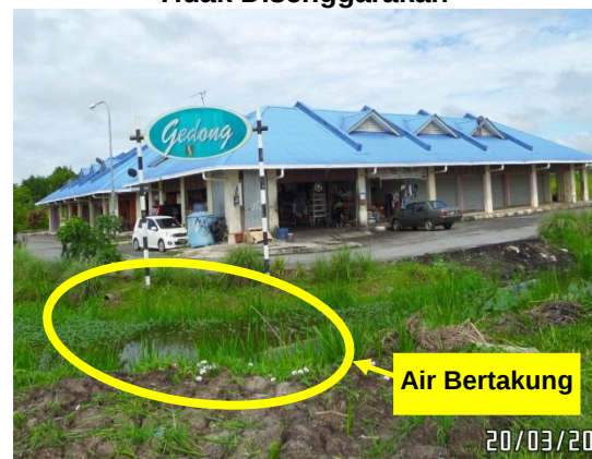
Gambar 2.30 Longkang Di Tepi Gerai Tidak Disenggara
