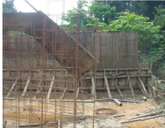
Gambar 1.9 Pembinaan Pembentung No. 5 Siap Setakat Apron Leveland
