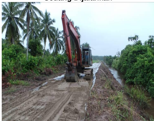
Gambar 1.14 Kerja Penimbusan Pasir Di Garis A1-R6-N- Sedang Dijalankan
