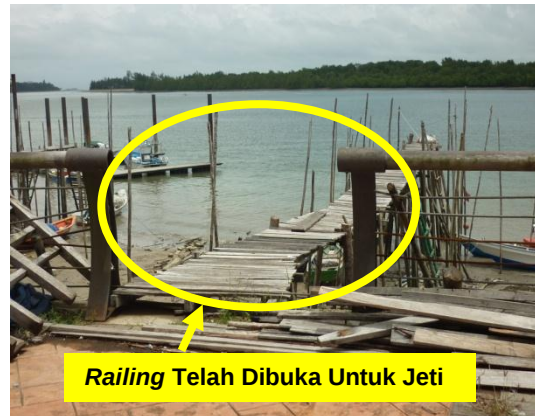
Gambar 2.26 Railing Di Tebingan Sungai Diubahsuai
