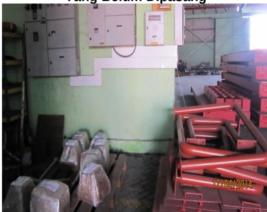
Gambar 6.1 Komponen Weighbridge Yang Belum Dipasang
