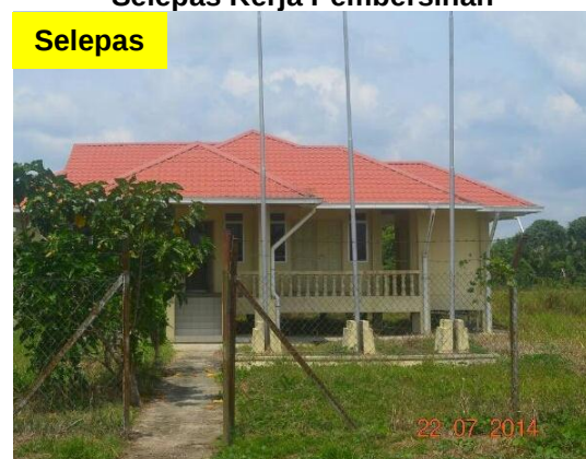
Gambar 2.14 Kawasan Bangunan JKR Depo Beladin Selepas Kerja Pembersihan
