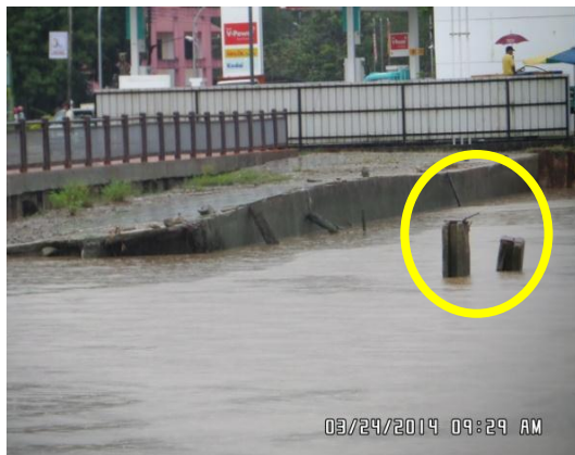
Gambar 1.3 Cerucuk Masih Terpacak Di Sungai
