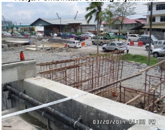
Gambar 1.12 Kerja Pembinaan Sedang Dijalankan
