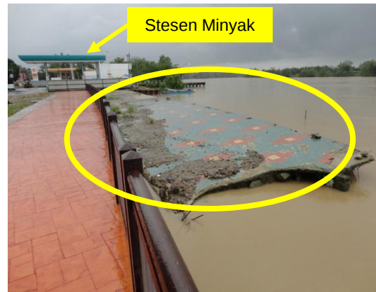
Gambar 1.2 Struktur Tebingan Sungai Lama Tidak Diroboh
