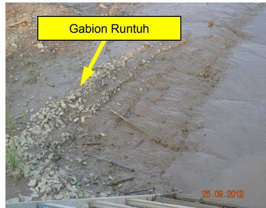
Gambar 2.12 Gabion Runtuh
