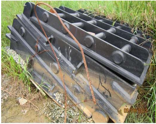
Gambar 2.18 Flap Gates Tidak Disimpan Dengan Sempurna
