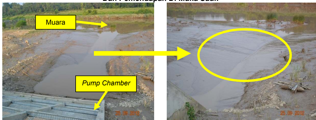
Gambar 2.16 Pump Chamber Jauh Dari Muara Serta Pengelodakan Dan Pemendapan Di Muka Sauk
