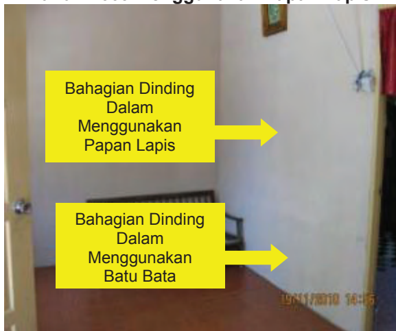
Gambar 2.37 Sebahagian Dinding Dalam Rumah Jenis Batu Bata 3 Bilik Bagi Tahun 2009 Menggunakan Papan Lapis
