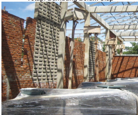
Gambar 6.3 Peralatan Sudah Ada Tetapi Bumbung Belum Siap
