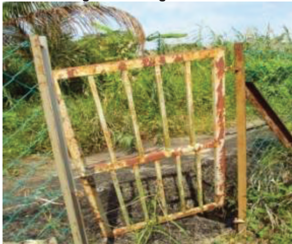
Gambar 8.15 Pintu Pagar Belakang Rumah Rosak
