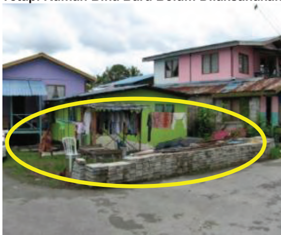
Gambar 2.19 Kawasan Rumah Asal Penerima PBR Yang Telah Dirobohkan Tetapi Rumah Bina Baru Belum Dilaksanakan
