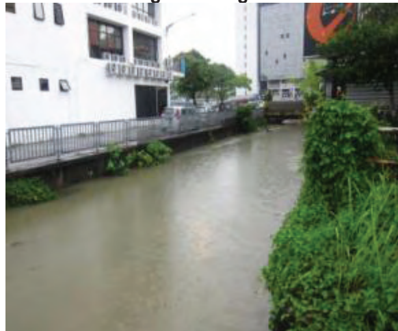
Gambar 7.6 RTB Sungai Padungan Fasa 2
