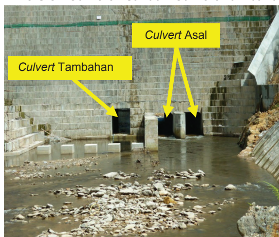
Gambar 3.1 Diversion Culvert Asal dan Culvert Tambahan
