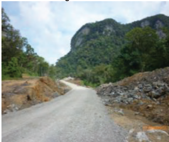
Gambar 3.6 Jalan Ke Skim Penempatan Semula Penduduk Bengoh Pada Bulan Mac 2011
