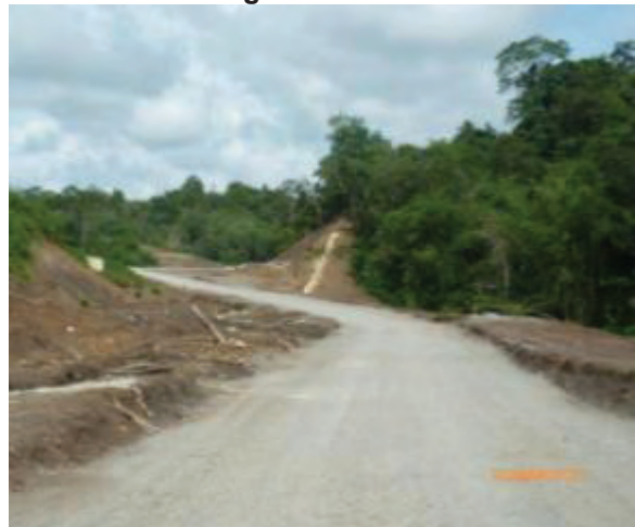
Gambar 3.7 Jalan Ke Skim Penempatan Semula Penduduk Bengoh Pada Bulan Mac 2011
