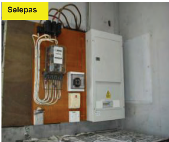
Gambar 5.16 Pendawaian Elektrik Selepas Disenggara
