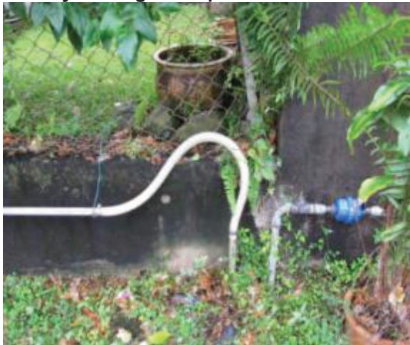
Gambar 11.10 Penyambungan Tanpa Melalui Meter Air
