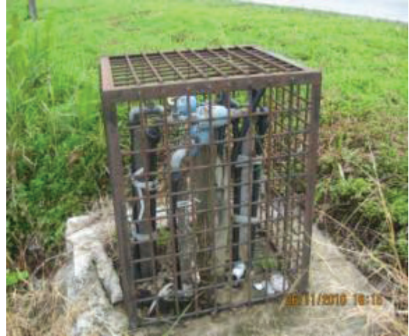
Gambar 11.9 Meter Air Dalam Jeriji Besi
