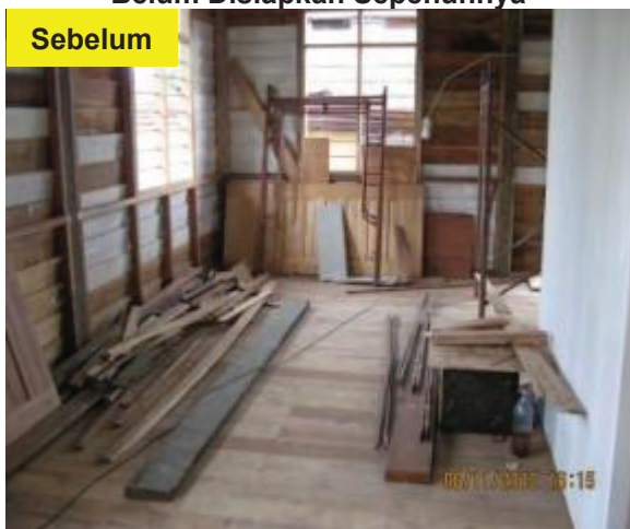
Gambar 2.26 Pembinaan Rumah Belum Disiapkan Sepenuhnya
