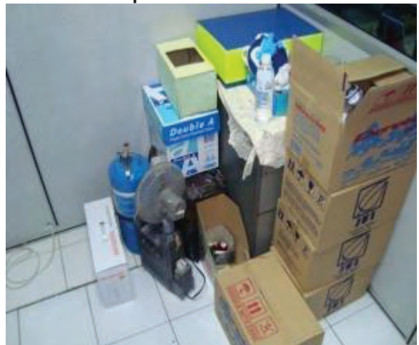
Gambar 4.4 Barang Yang Tidak Diperlukan Disimpan Dalam Bilik Server
