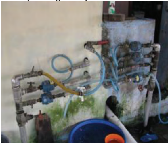
Gambar 11.12 Penyambungan Tanpa Melalui Meter Air
