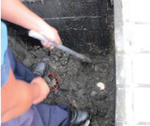
Gambar 11.8 Meter Air Dalam Debris
