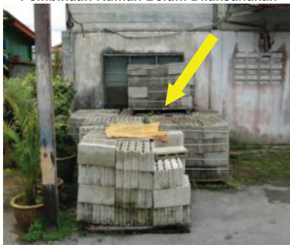
Gambar 2.20 Bahan Binaan Diletakkan Terbiar Di Tepi Jalan Tetapi Pembinaan Rumah Belum Dilaksanakan
