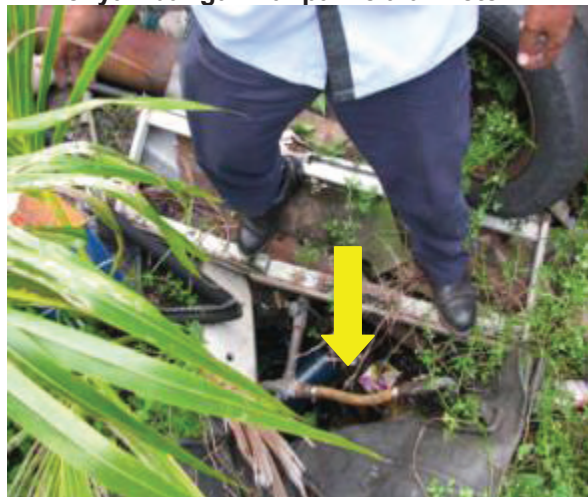
Gambar 11.13 Penyambungan Tanpa Melalui Meter Air
