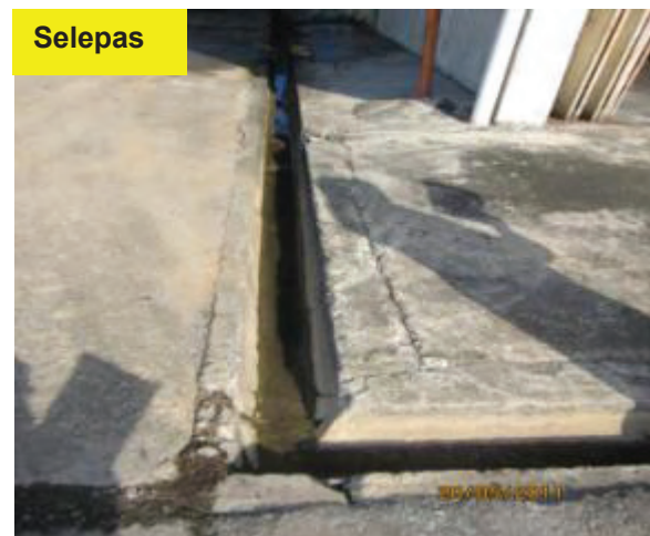
Gambar 5.8 Longkang Yang Telah Dibersihkan
