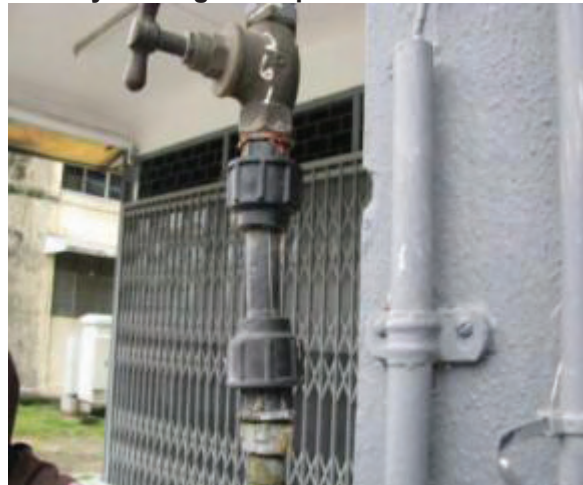
Gambar 11.11 Penyambungan Tanpa Melalui Meter Air
