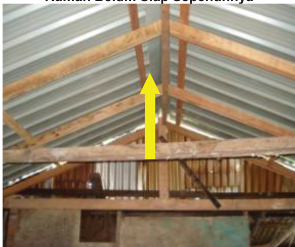
Gambar 2.33 Kerja Baik Pulih Atap Rumah Belum Siap Sepenuhnya
