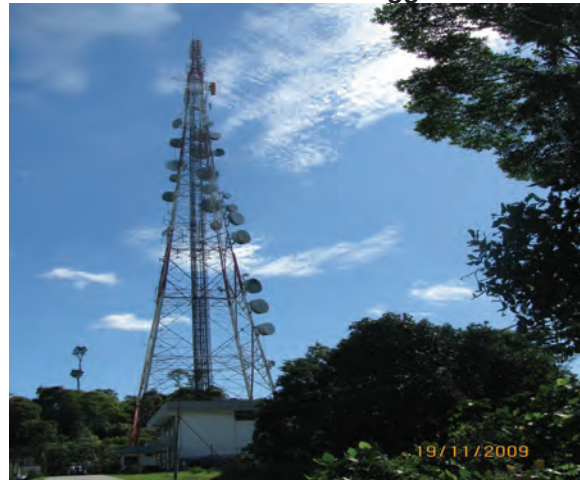
Foto 13.4 Menara Jenis 4 - Legged
