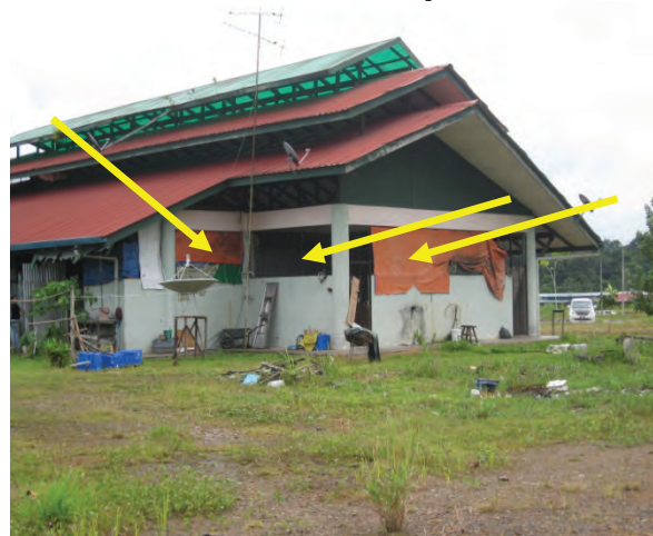
Foto 9.15 Bahagian Tiada Berdinding Dimasuki Air Hujan
