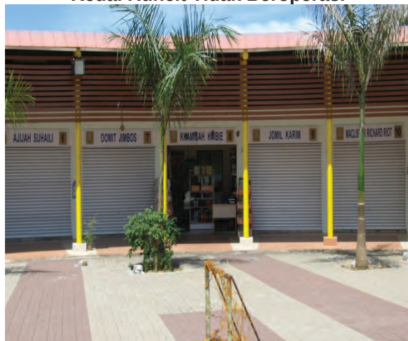
Foto 9.21 Kedai Runcit Tidak Beroperasi
