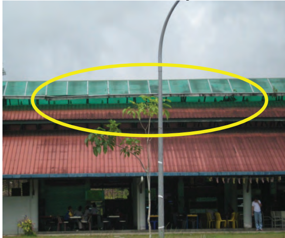
Foto 9.14 Reka Bentuk Struktur Bumbung Dimasuki Air Hujan
