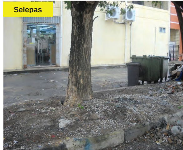
Foto 2.20 Kerja Pembersihan Telah Dilakukan
