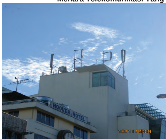
Menara Telekomunikasi Yang Dibina Atas Bumbung Bangunan
