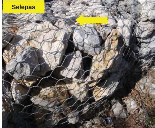
Foto 3.8 Benteng Gabion Yang Telah Dibaiki
