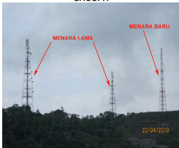
Foto 13.15 Menara Telekomunikasi Milik Syarikat Telekomunikasi Dan Yang Dibina Oleh SACOFA
