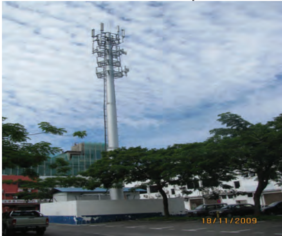
Foto 13.1 Menara Jenis Monopole
