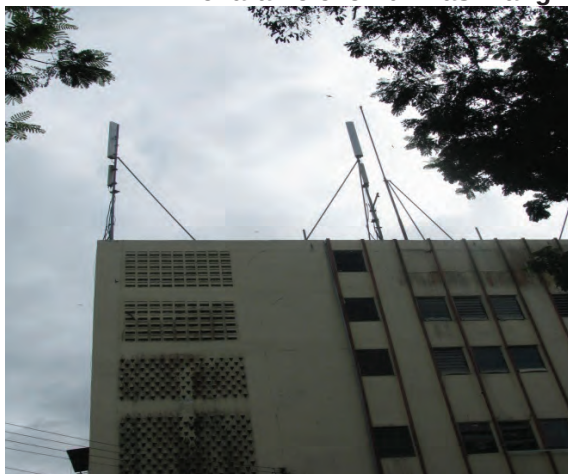
Foto 13.13 Menara Telekomunikasi Yang Dibina Atas Bumbung Bangunan
