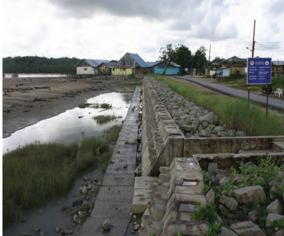
Foto 9.1 Benteng Penahan Hakisan Dibina Oleh Jabatan Pengairan Dan Saliran
