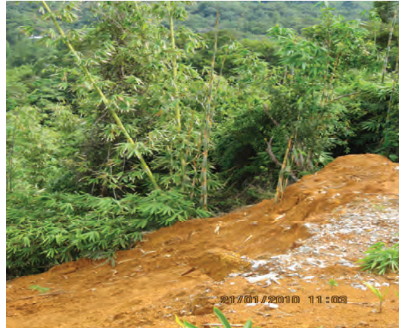
Foto 13.6 Hakisan Dan Tanah Runtuh Mula Berlaku Di Kawasan Tambakan Tanah
