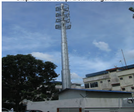
Foto 13.12 Menara Jenis Monopole Telah Siap Dibina Tetapi Belum Digunakan
