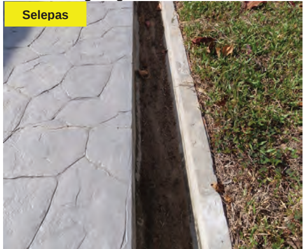
Foto 3.10 Longkang Telah Dibersihkan
