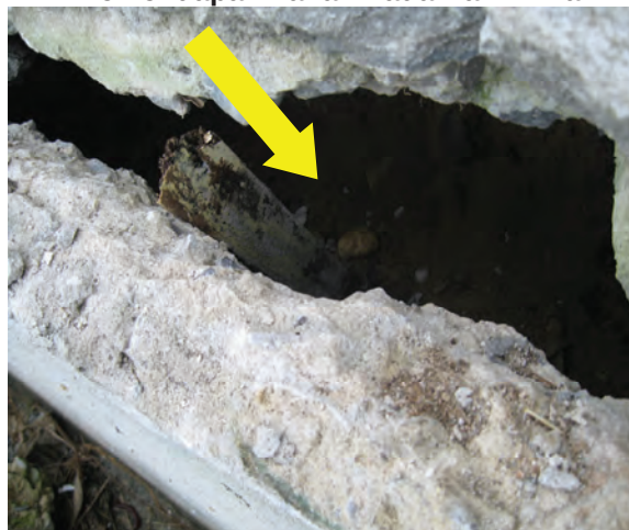
Foto 10.5 Pemendapan Tanah Pada Kaki Lima
