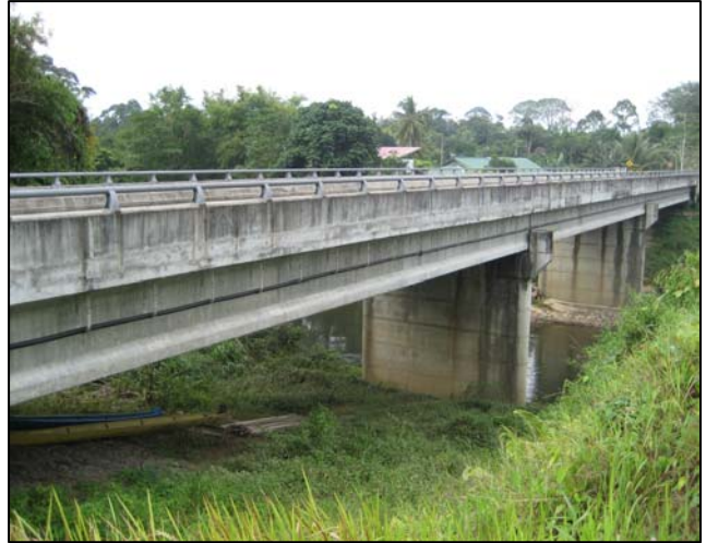
Foto 10 Jambatan Yang Dilaksanakan Secara Tender Terbuka
