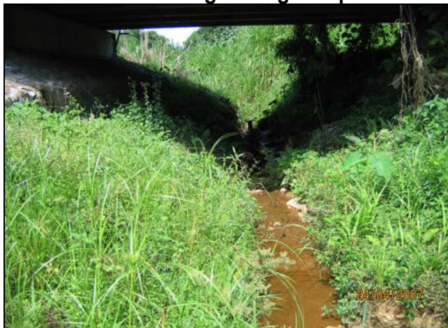
Foto 15 Jambatan Konkrit Satu Rentang Sepanjang 16.5 Meter Yang Dibina Di atas Sungai Yang Sempit
