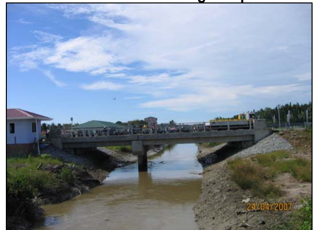
Foto 16 Jambatan Konkrit Dua Rentang Sepanjang 19.5 Meter Yang Dibina Di atas Terusan Yang Sempit
