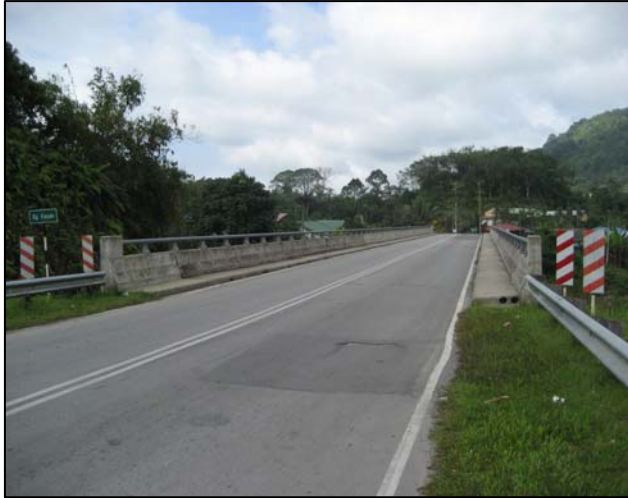
Foto 9 Jambatan Yang Dilaksanakan Secara Tender Terbuka
