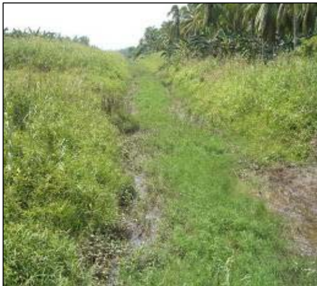
Foto 48 Pembersihan Parit Tidak Dijalankan
