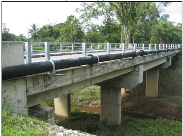
Foto 12 Jambatan Yang Dilaksanakan Di Bawah Projek Penggantian Jambatan
