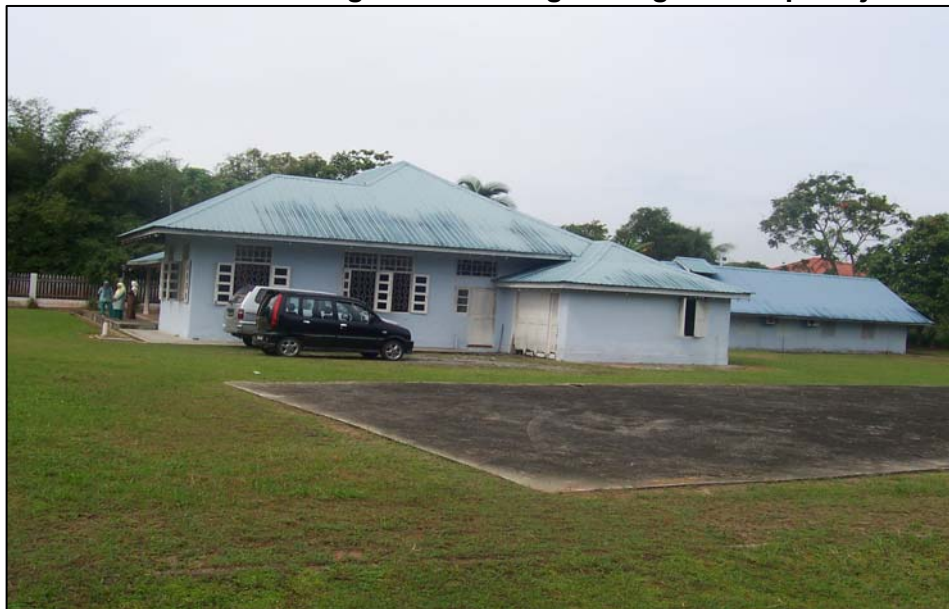
Foto 34 Kuarters Lama Digunakan Sebagai Bangunan Dapur Uji
