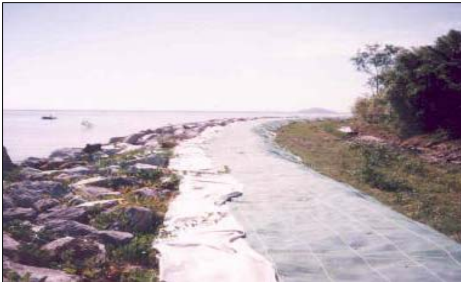
Foto 50 Pembaikan Tebatan Pesisiran Pantai Menggunakan Geotextile
