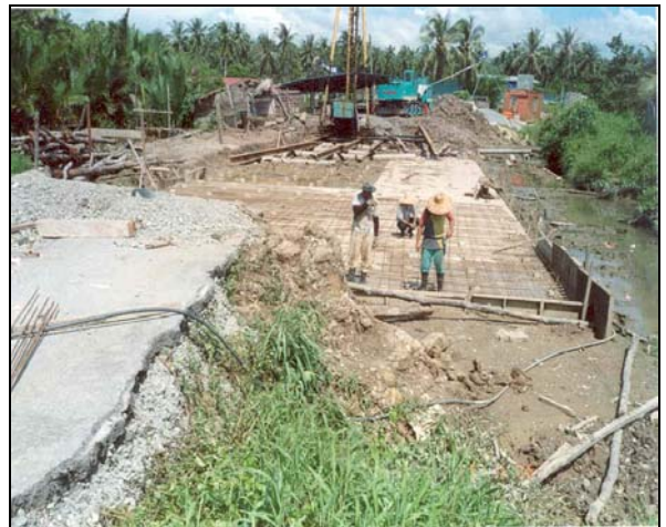
Foto 18 Kerja Membina Papak Konkrit Sedang Dijalankan Di Susur Masuk Jambatan Kerana Tanah Lembut
