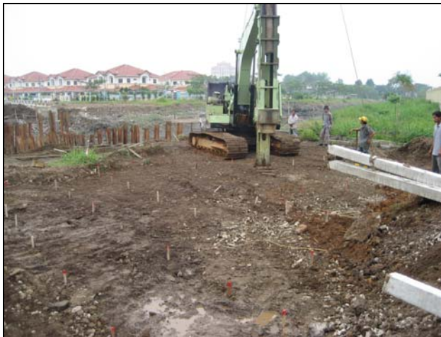
Foto 17 Penanaman Cerucuk Sedang Dijalankan Di Susur Masuk Jambatan Kerana Tanah Lembut
