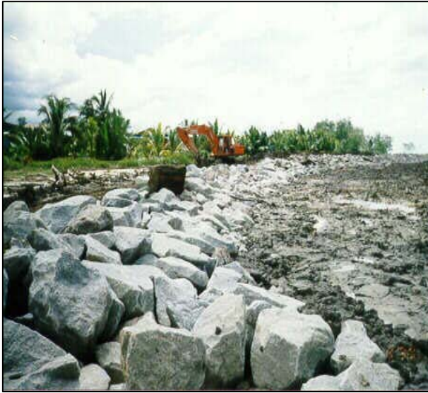
Foto 41 Kerja Pembinaan Benteng Tebatan Pesisiran Pantai Sedang Dijalankan
