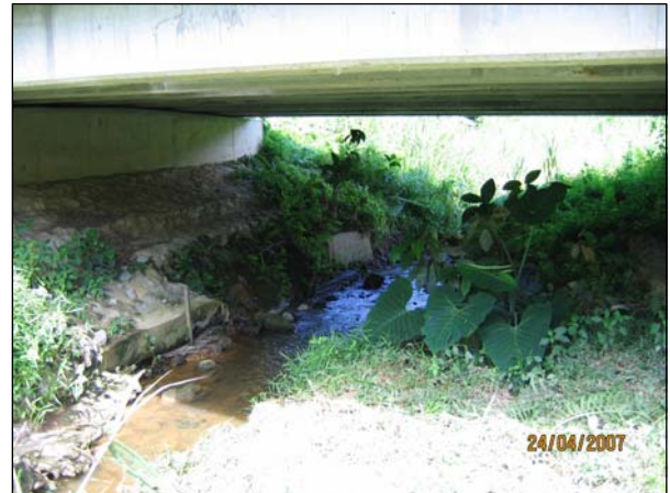
Foto 14 Jambatan Konkrit Satu Rentang Sepanjang 16.5 Meter Yang Dibina Di atas Sungai Yang Sempit
