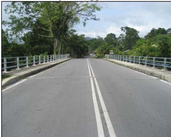
Foto 11 Jambatan Yang Dilaksanakan Di Bawah Projek Penggantian Jambatan
