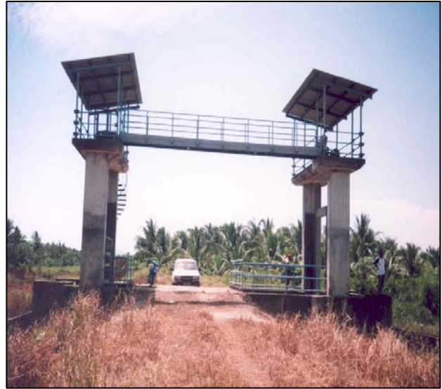
Foto 36 Pintu Kawalan Air Berkembar Bagi Mengawal Paras Air
