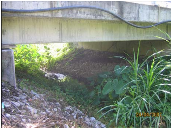
Foto 13 Jambatan Konkrit Satu Rentang Sepanjang 16.5 Meter Yang Dibina Di atas Sungai Yang Sempit
