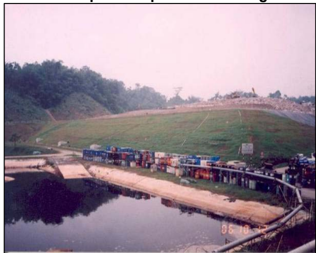
Foto 85 Pemandangan Tapak Pelupusan Di Tapak Pelupusan Mambong
