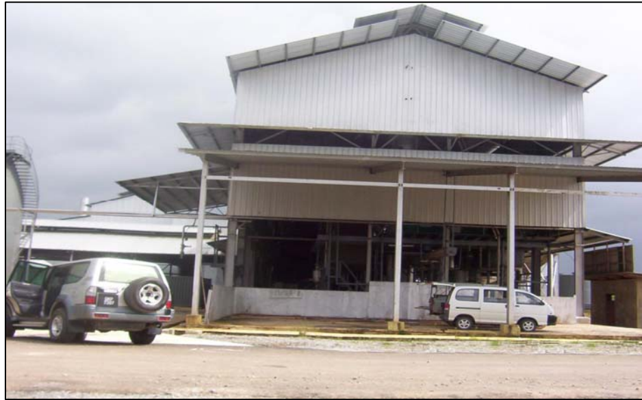
Foto 100 Harta Pegangan Yang Telah Siap Dibina Pada Awal Tahun 2006 Belum Diukur Periksa
