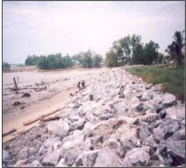
Foto 42 Kerja Pembinaan Benteng Tebatan Pesisiran Pantai Siap Dijalankan
