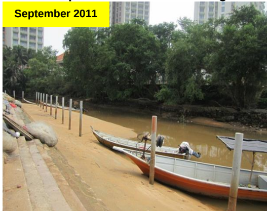
Gambar 2.13 Mendapan Pasir Di Muara Sungai Lereh Yang Mengganggu Laluan Bot Nelayan
