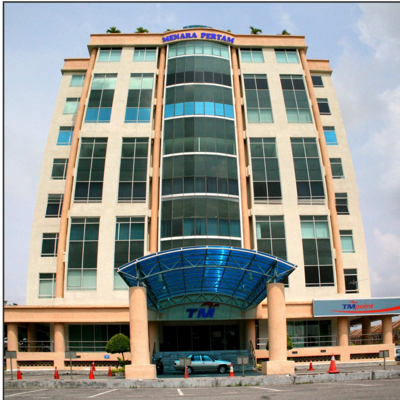
Foto 1 Bangunan Menara PERTAM
