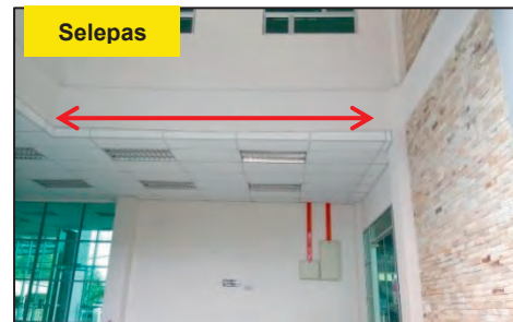
Courtyard, MAN Keningau - Levelling Slab Tidak Selari Telah Dibaiki (Sumber: JKR)
