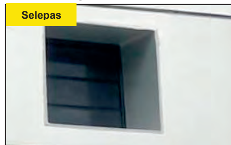
Tandas Aras Bawah, MAN Keningau - Exhaust Fan Shutter Telah Dibaiki (Sumber: JKR)
