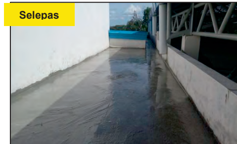
Ruang Atap, MAN Keningau - Lantai Telah Dibaiki (Sumber: JKR)
