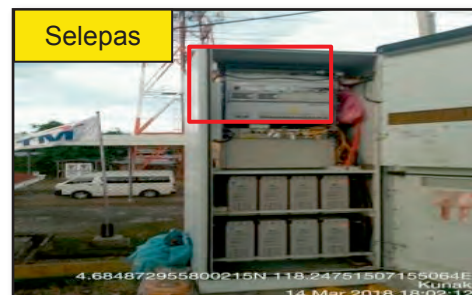
Leg A TM Kunak - Maklum Balas : Rectifier Tidak Berfungsi (14.03.2018) (Sumber: S.Comm)
