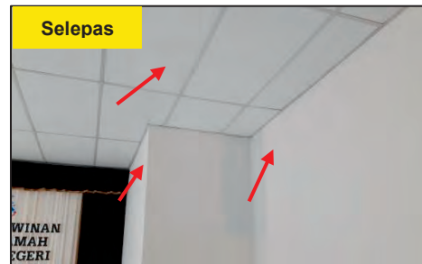
Ruang WKAN, MAN Penampang Siling Diresapi Air Telah Dibaiki (Sumber: JKR)
