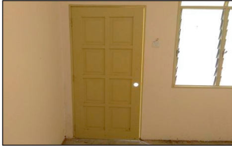
RMMK Taman Wadi Iman Pasir Genda Tanah Merah - Tombol Pintu yang Ditanggalkan (6.3.2019)
