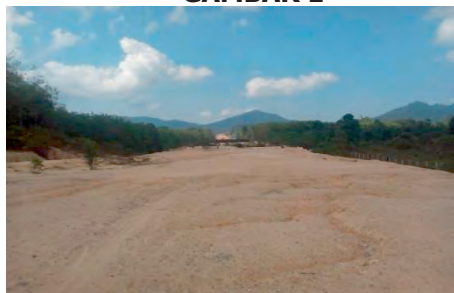
Tapak Pembinaan Lebuhraya Rakyat 10 km Bukit Tiu – Berangan Mek Nab (08.04.2019) (Sumber: Jabatan Audit Negara)
