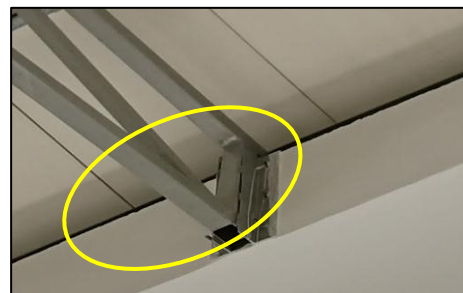
Dewan Serbaguna di Pasar Awam -Steel Truss Untuk Bumbung Tidak Mempunyai Support yang Sepatutnya ( Hot Rolled Steel ) (4.8.2018)
