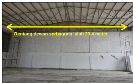
Dewan Serbaguna di Pasar Awam -Steel Truss Untuk Bumbung Tidak Mempunyai Support yang Sepatutnya ( Hot Rolled Steel ) (4.8.2018)
