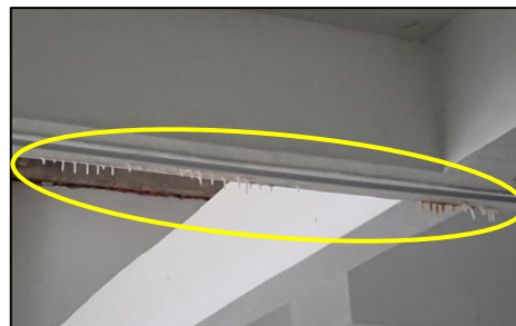
Kompleks Masjid -Terdapat Resapan Air pada Siling Sehingga Membentuk Stalaktit (2.8.2018)
