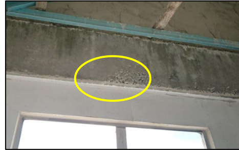
Bilik Ahli Majlis MPKB-BRI di Pasar Awam -Struktur Rasuk Tidak Dibina Dengan Sempurna. (2.8.2018)
