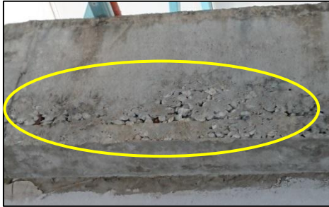
Bilik Ahli Majlis MPKB-BRI di Pasar Awam -Struktur Rasuk Tidak Dibina Dengan Sempurna. (2.8.2018)
