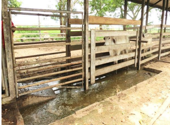
Gambar 6.8 Air Bertakung Di Kandang Rawatan
