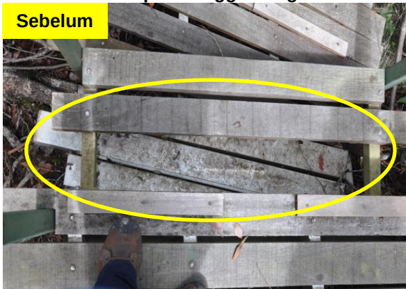
Gambar 7.59 Jarak Papan Tangga Yang Jauh
