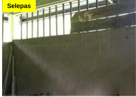
Gambar 7.4 Kerja Menyimen Dinding Genset Room Telah Dibuat
