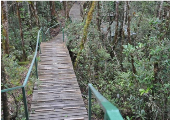
Gambar 7.59 Jarak Papan Tangga Yang Jauh
