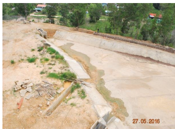
Gambar 2.5 Saliran Dalam Pembinaan
