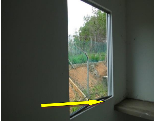
Gambar 8.16 Cermin Tingkap Hilang
