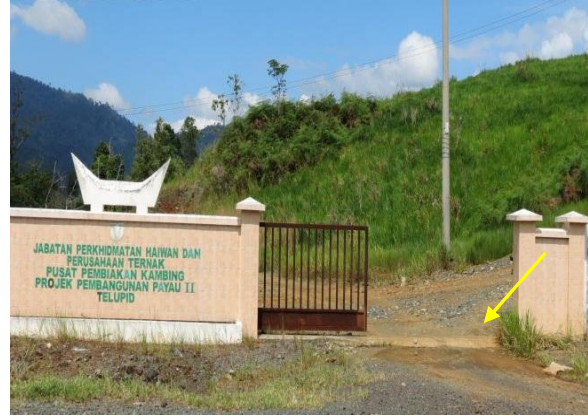
Gambar 6.17 Vehicle Dip Tidak Disediakan Di Pintu Masuk Ladang
