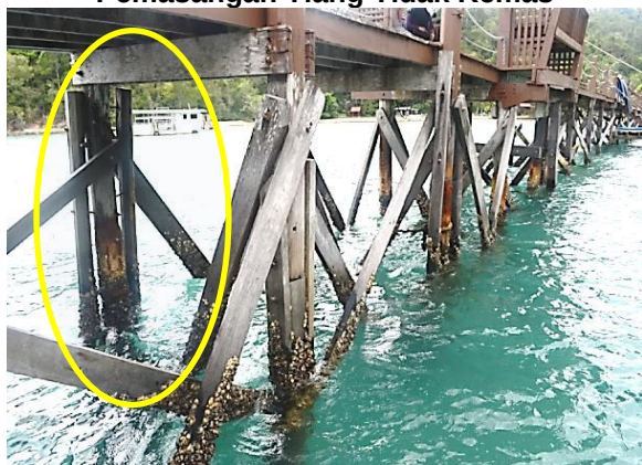
Gambar 5.1 Pemasangan Tiang Tidak Kemas
