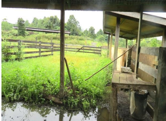
Gambar 6.16 Kandang Rawatan Dan Pemeriksaan Lembu Tidak Disenggara Dengan Baik
