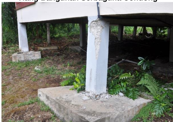
Gambar 7.47 Tiang Bangunan Serbaguna Condong
