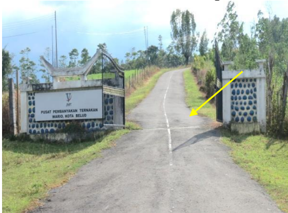
Gambar 6.22 Vehicle Dip Tidak Disediakan Di Pintu Masuk Ladang
