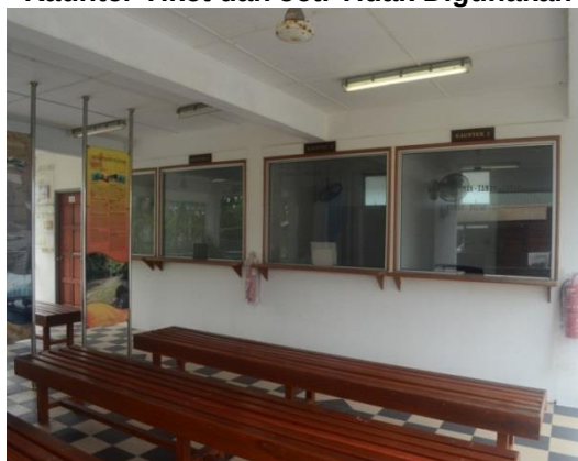
Gambar 5.12 Kaunter Tiket dan Jeti Tidak Digunakan
