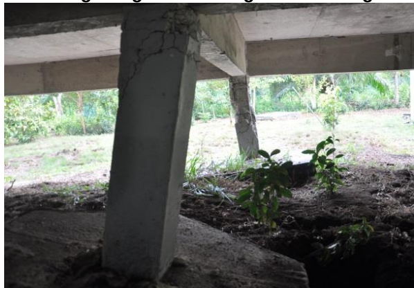
Gambar 7.46 Tiang Bangunan Serbaguna Condong
