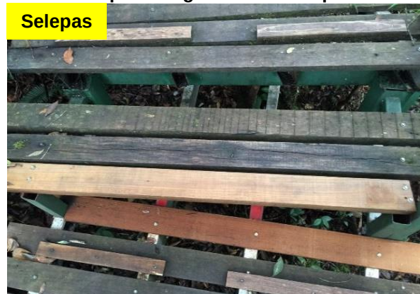
Gambar 7.60 Jarak Papan Yang Jauh Telah Diperbaiki
