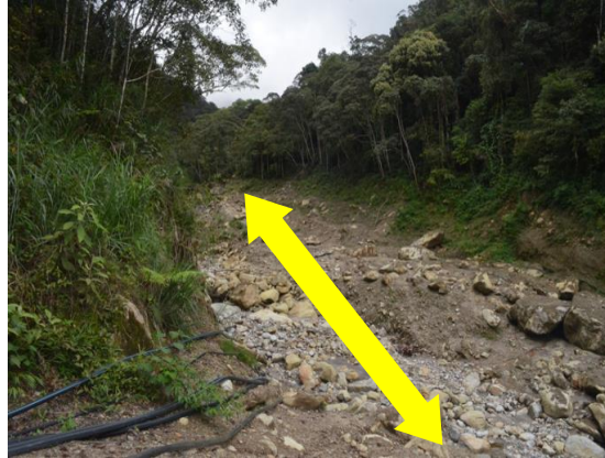
Gambar 5.14 Jalan Utama Rosak Dan Terputus
