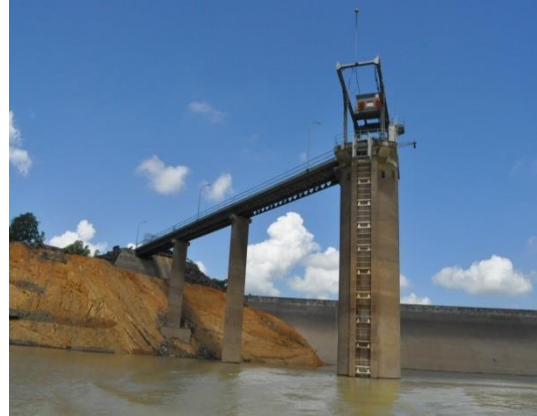
Gambar 3.2 Menara Kawalan Empangan Babagon
