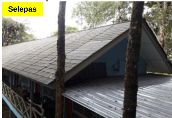
Gambar 7.40 Atap Resthouse Telah Dibaiki
