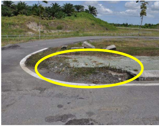
Gambar 3.8 Walkpath – Paver Block Yang Mendap
