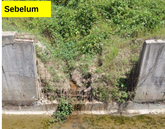
Gambar 3.18 Inlet Drainage Tidak Sempurna
