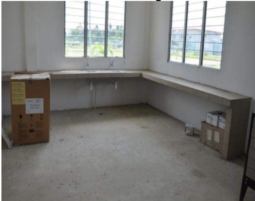
Gambar 3.40 Makmal Tidak Digunakan
