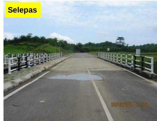
Gambar 3.27 Hard Stand Guardrail Telah Dicat Hitam Putih
