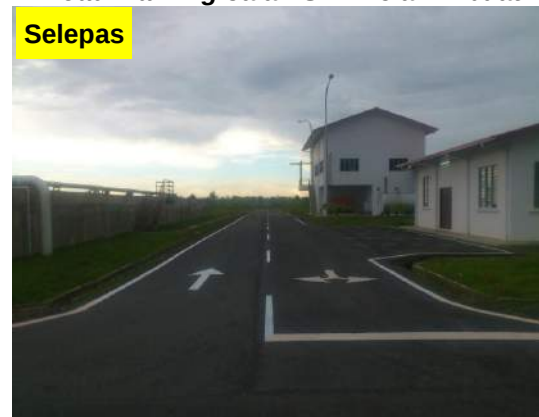
Gambar 3.37 Road Marking Jalan STP Telah Dibuat
