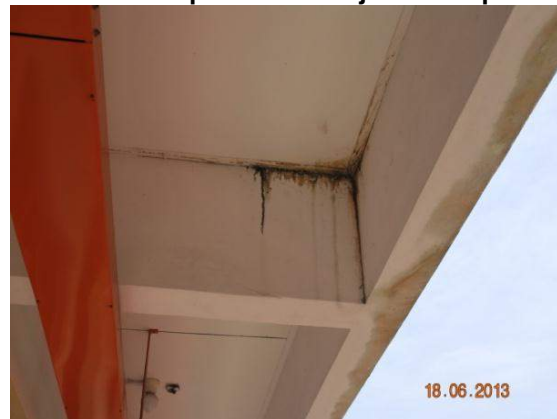
Gambar 1.14 Air Meresap Setelah Kerja Menampal
