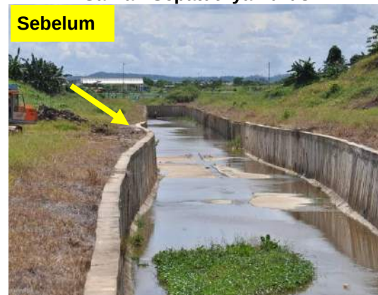
Gambar 3.16 Saliran Sepatutnya Lurus
