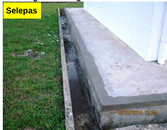
Gambar 3.11 Tebing Parit Yang Pecah Telah Dibaiki
