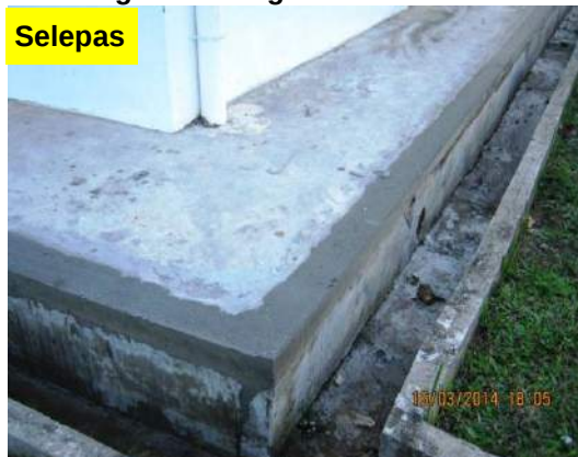
Gambar 3.13 Tebing Parit Yang Pecah Telah Dibaiki
