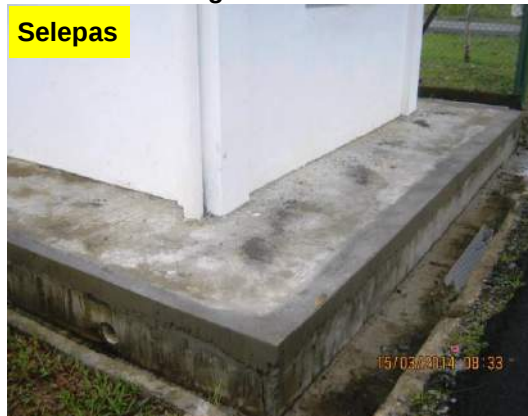
Gambar 3.15 Lantai Dan Tebing Parit Retak Telah Dibaiki
