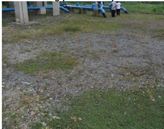
Gambar 3.22 Close Turfing (Flat Ground) Tidak Rata
