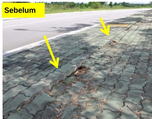
Gambar 3.8 Walkpath – Paver Block Yang Mendap
