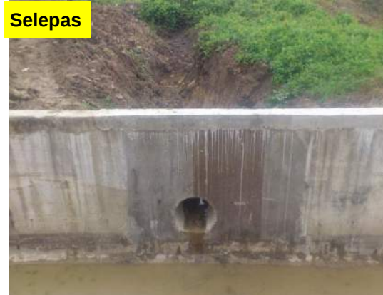
Gambar 3.19 Inlet Drainage Telah Dibaiki
