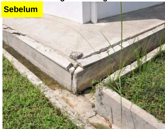
Gambar 3.12 Tebing Parit Yang Pecah
