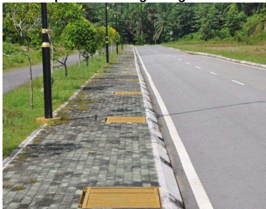
Gambar 3.30 Penutup Saliran Yang Menggunakan Besi
