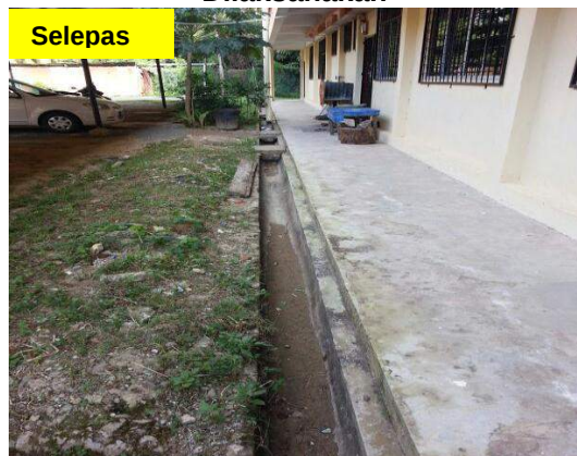
Gambar 1.26 Kerja Pembersihan Longkang Telah Dilaksanakan
