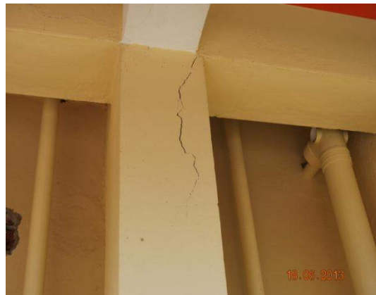
Gambar 1.8 Keretakan Struktur
