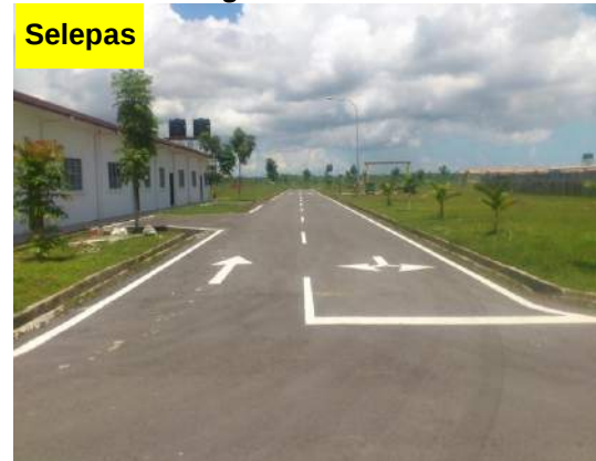
Gambar 3.35 Road Marking Jalan STP Telah Dibuat
