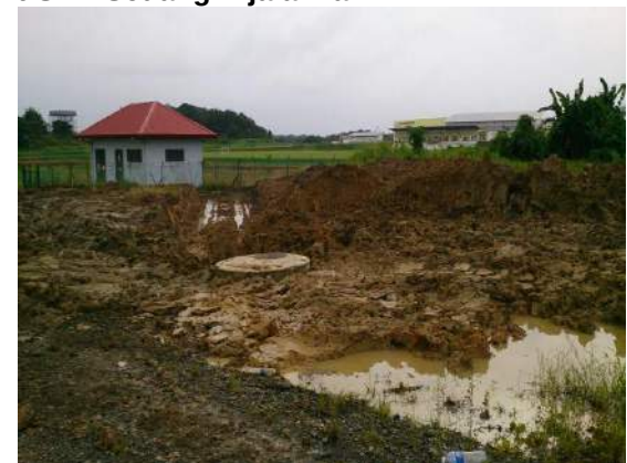
Gambar 3.51 Kerja Penyambungan Paip Pembentungan Dari MRSM Ke Sewerage Treatment Plant SEH Sedang Dijalankan
