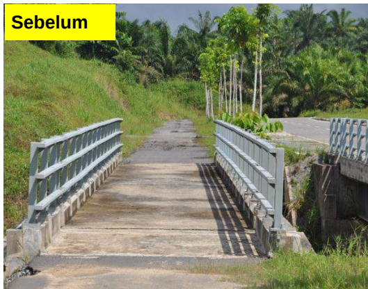
Gambar 3.28 Hard Stand Guardrail Tidak Dicat Hitam Putih
