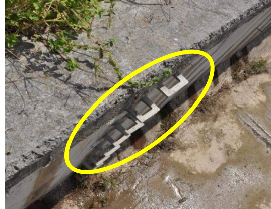
Gambar 3.33 Tangga Yang Sepatutnya Dipasang
