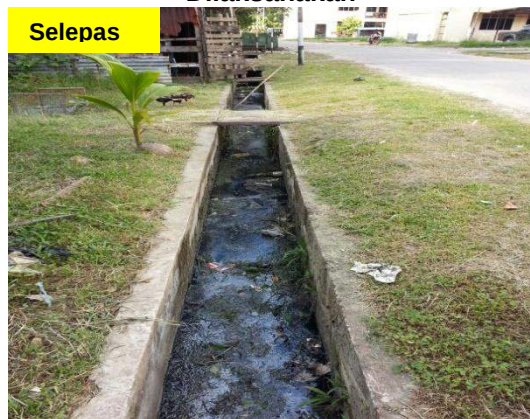
Gambar 1.30 Kerja Pembersihan Longkang Telah Dilaksanakan
