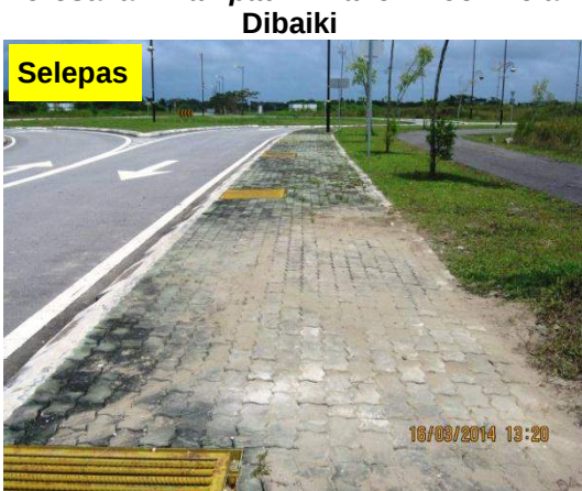
Gambar 3.6 Kerosakan Walkpath – Paver Block Telah Dibaiki
