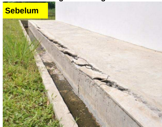
Gambar 3.10 Tebing Parit Yang Pecah
