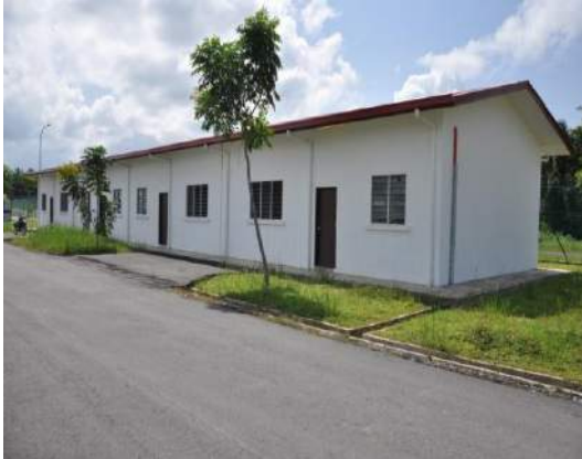
Gambar 3.38 Labour Quarters Tidak Didiami
