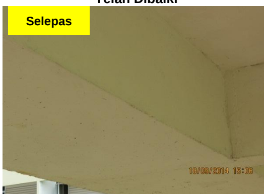
Gambar 1.6 Permukaan Konkrit Bangunan Pecah Telah Dibaiki
