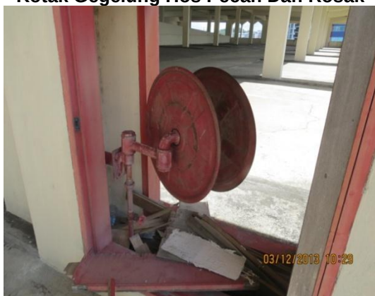
Gambar 6.1 Kotak Gegelung Hos Pecah Dan Rosak
