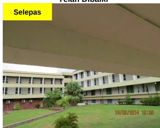
Gambar 1.8 Permukaan Konkrit Bangunan Pecah Telah Dibaiki
