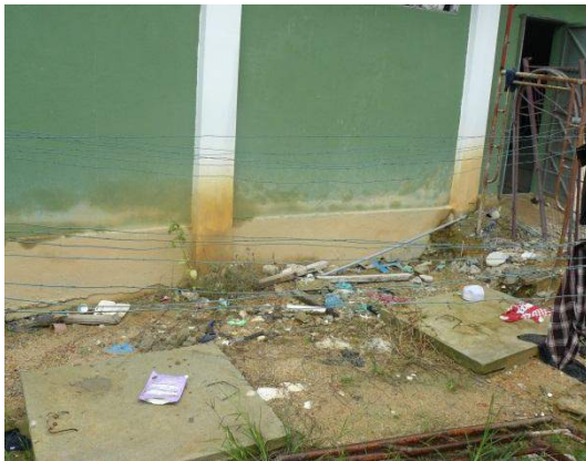
Gambar 1.6 Sisa Bahan Binaan Tidak Dibersihkan
