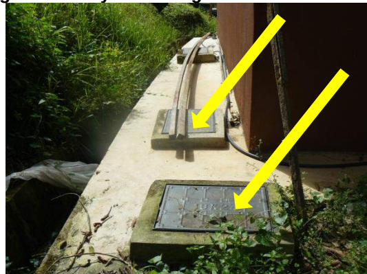
Gambar 1.43 Penutup Tangki Jenis Polythene Yang Membahayakan Penghuni Asrama
