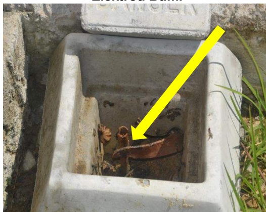
Gambar 1.29 Kabel Bumi Tidak Dipateri Kepada Elektrod Bumi
