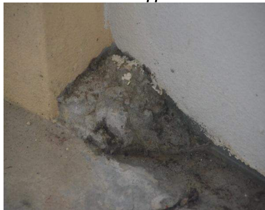
Gambar 1.16 Mortar Di Scupper Drain
