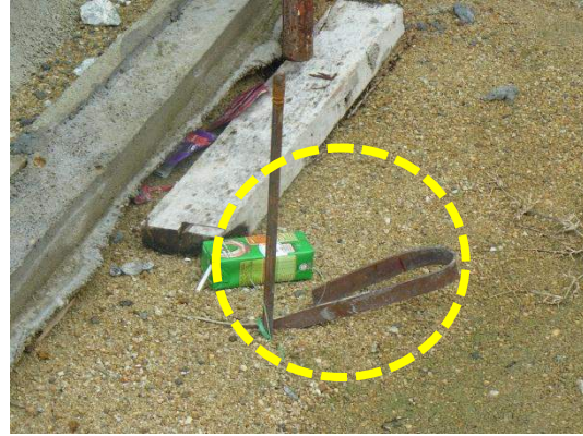
Gambar 1.32 Tamatan Pada Pita Kuprum Terdedah Dan Tidak Dibumikan
