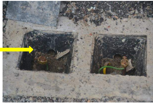
Gambar 1.30 Kotak Pembedian Jenis Polythene Tidak Sesuai Dan Mudah Pecah
