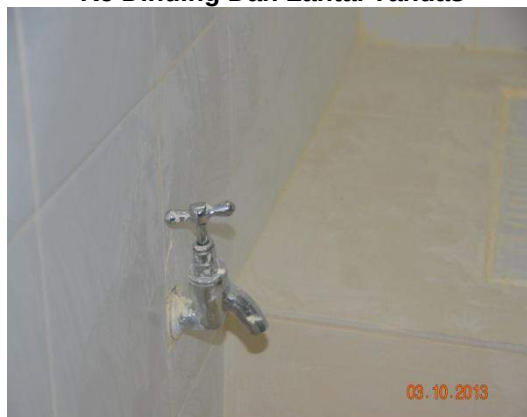
Gambar 1.22 Kepala Paip Terlalu Rapat Ke Dinding Dan Lantai Tandas
