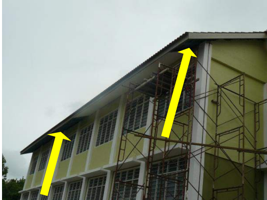
Gambar 1.3 Pemasangan Siling Belum Siap Sepenuhnya
