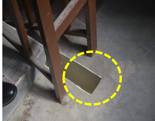
Gambar 1.18 Lubang Antara Tangga Tingkat 1 Dan 2 Asrama
