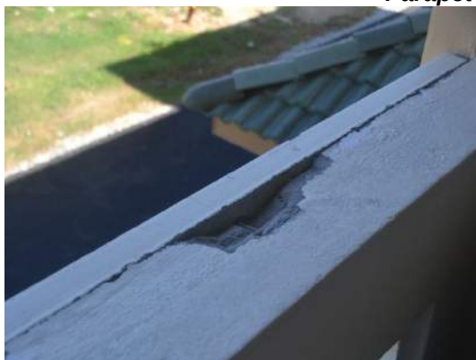
Parapet Wall Retak
