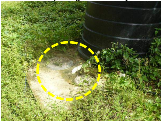
Gambar 1.43 Penutup Tangki Jenis Polythene Yang Membahayakan Penghuni Asrama
