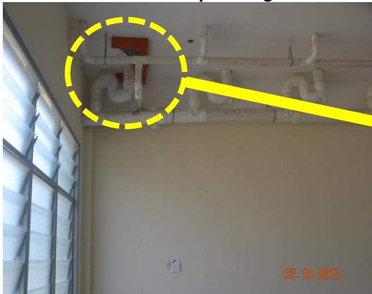
Gambar 1.40 Pendawaian Elektrik Antara Paip Buangan Kumbahan Dan Paip Air Buangan
