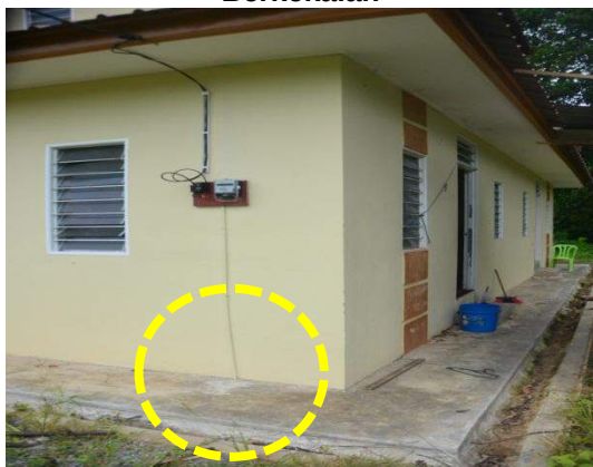
Gambar 1.28 Elektrod Bumi Dikongkrit Secara Berkekalan
