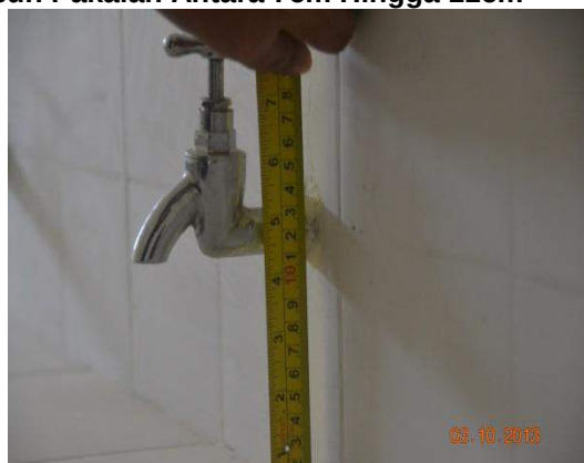
Gambar 1.23 Ketinggian Paip Air Di Tempat Membasuh Pakaian Antara 7cm Hingga 11cm
