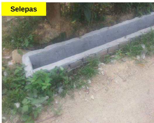
Gambar 2.4 Penghujung Longkang Telah Dibuat
