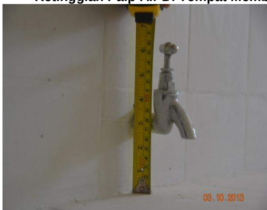
Gambar 1.23 Ketinggian Paip Air Di Tempat Membasuh Pakaian Antara 7cm Hingga 11cm
