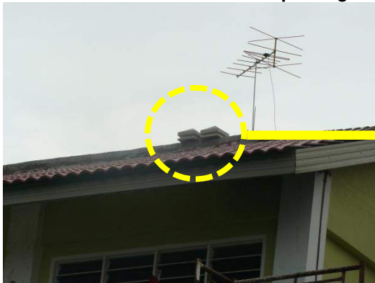
Gambar 1.5 Konkrit Penutup Tiang Ditinggalkan Di Atas Bumbung
