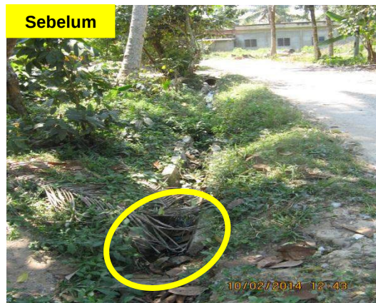
Gambar 2.2 Tiada Penghujung Longkang
