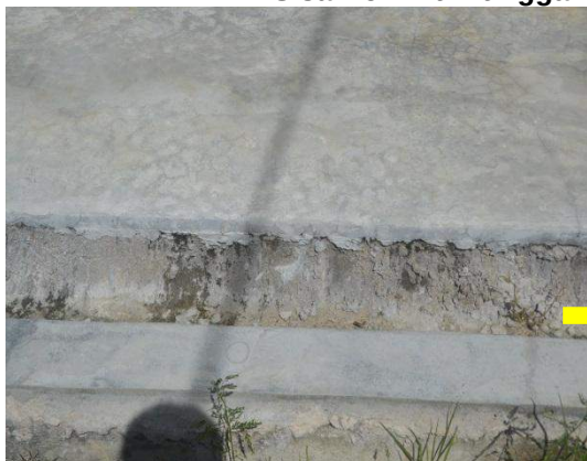
Gambar 1.17 Sisa Konkrit Ditinggalkan Dalam Longkang Tidak Dibersihkan
