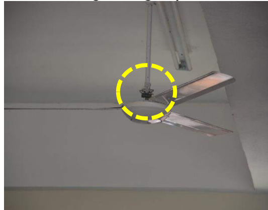
Gambar 1.46 Antara Salah Satu Kipas Siling Kehilangan Sengkuap Bawah
