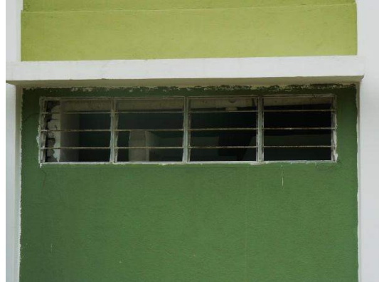
Gambar 1.4 Tingkap Cermin Sisip Angin Belum Dipasang
