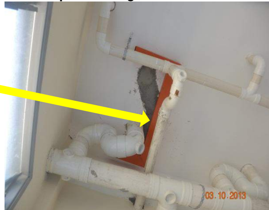
Gambar 1.40 Pendawaian Elektrik Antara Paip Buangan Kumbahan Dan Paip Air Buangan
