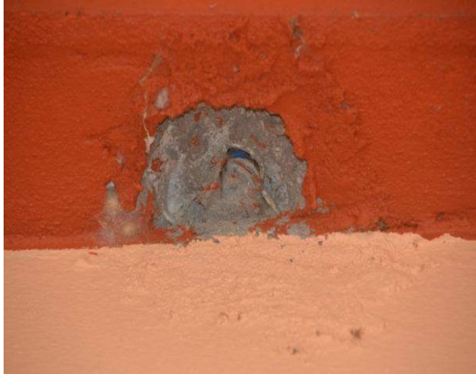
Gambar 1.38 Junction Box Terbenam Dalam Konkrit Secara Kekal
