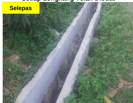
Gambar 2.3 Lepaan Simen Pada Penyambungan Setiap Longkang Telah Dibuat
