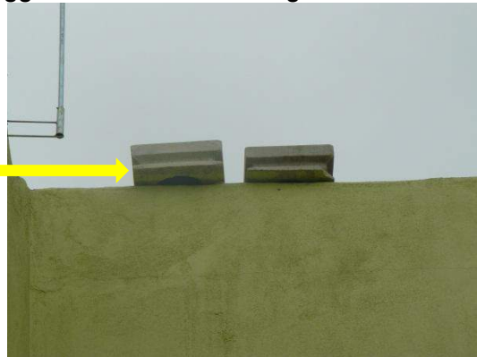
Gambar 1.5 Konkrit Penutup Tiang Ditinggalkan Di Atas Bumbung
