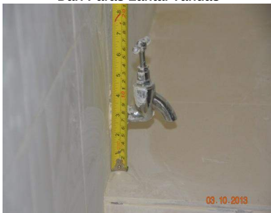
Gambar 1.21 Ketinggian Paip Hanya 7 cm Dari Paras Lantai Tandas
