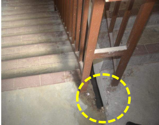
Gambar 1.18 Lubang Antara Tangga Tingkat 1 Dan 2 Asrama
