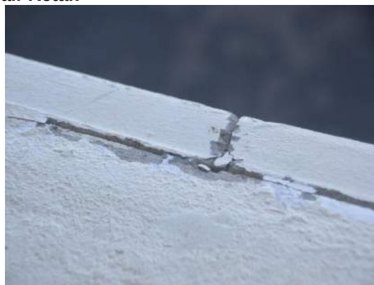
Parapet Wall Retak
