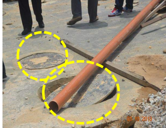
Gambar 1.41 Penutup Tangki Jenis Polythene Yang Membahayakan Penghuni Asrama
