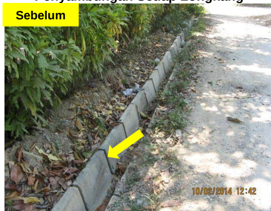
Gambar 2.1 Tiada Lepaan Simen Pada Penyambungan Setiap Longkang
