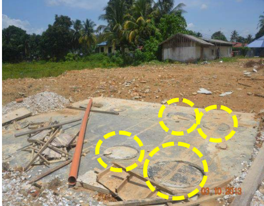
Gambar 1.41 Penutup Tangki Jenis Polythene Yang Membahayakan Penghuni Asrama
