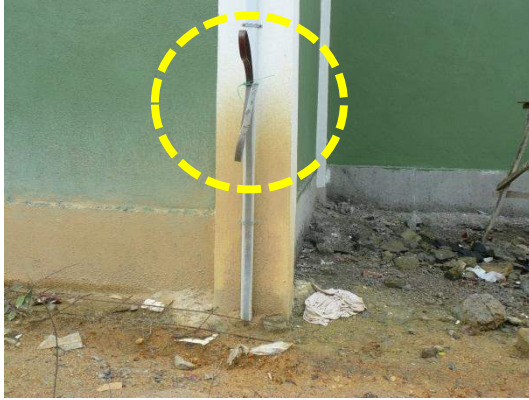
Gambar 1.32 Tamatan Pada Pita Kuprum Terdedah Dan Tidak Dibumikan
