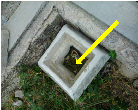
Gambar 1.31 Kabel Bumi Dan Elektrod Bumi Disatukan Dengan Kaedah Clam
