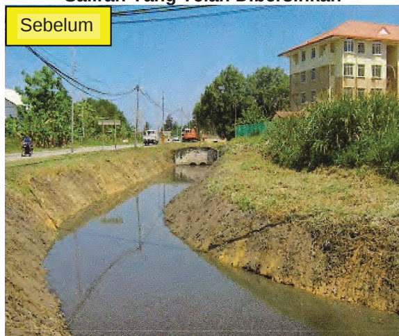
Foto 4.6 Saliran Yang Telah Dibersihkan
