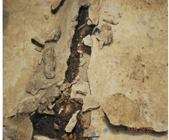
Foto 8.25 Keretakan Di Tempat Duduk Penonton
