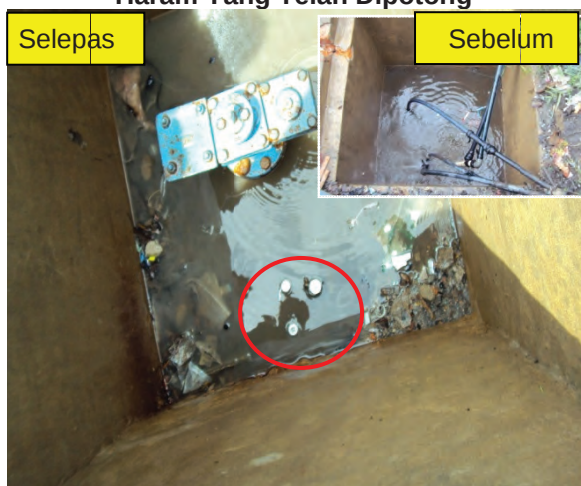
Foto 6.7 Sambungan Paip Haram Yang Telah Dipotong
