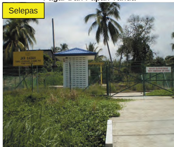
Foto 7.2 Pump Station 1 Telah Dilengkapi Pagar Dan Papan Tanda
