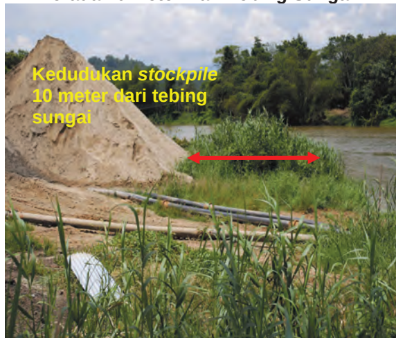
Foto 2.2 Kedudukan Stockpile Berada 10 Meter Dari Tebing Sungai
