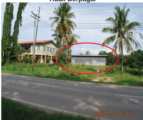
Foto 5.28 Kawasan Bangunan Stor Tidak Berpagar
