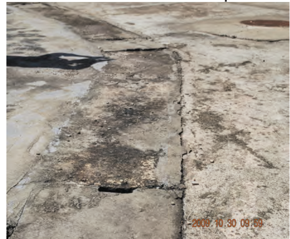
Foto 8.16 Kerja Kemasan Permukaan Konkrit Tidak Sempurna
