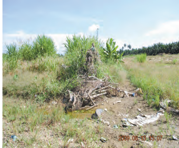
Foto 4.5 Keadaan Mendapan Di Kawasan Tengah Detention Pond
