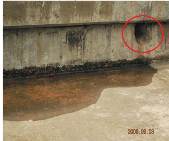
Foto 8.29 Corong Laluan Air Dibina Di Bawah Tempat Duduk Penonton
