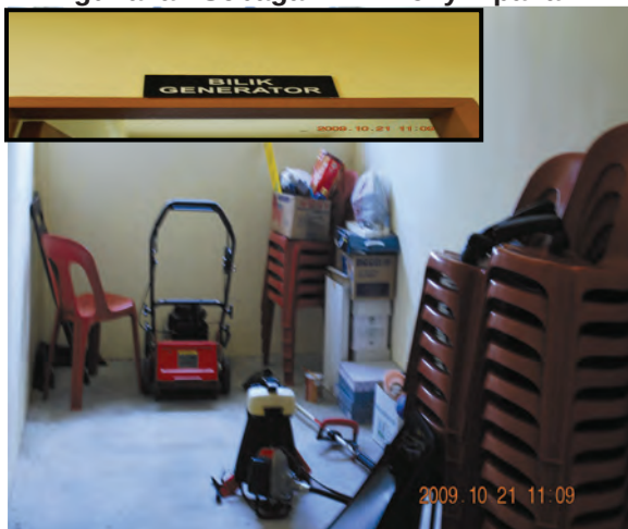
Foto 8.11 Bilik Generator Digunakan Sebagai Bilik Penyimpanan
