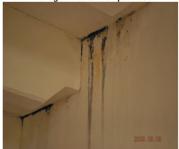
Foto 8.27 Resapan Air Di Bahagian Bawah Tempat Duduk
