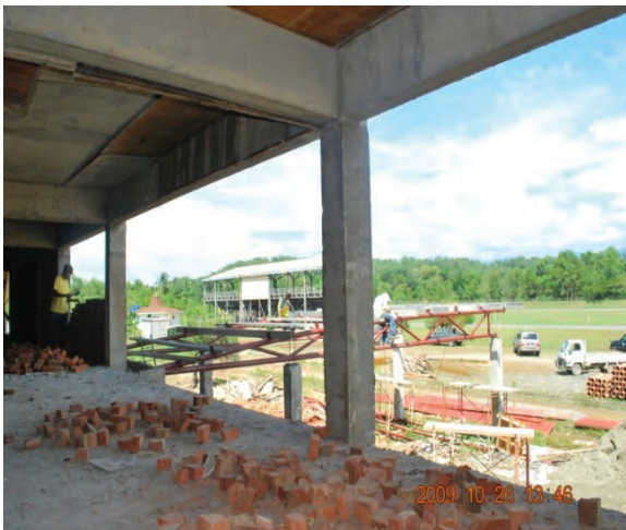
Foto 8.38 Stiffener Antara Tiang Tidak Dibina
