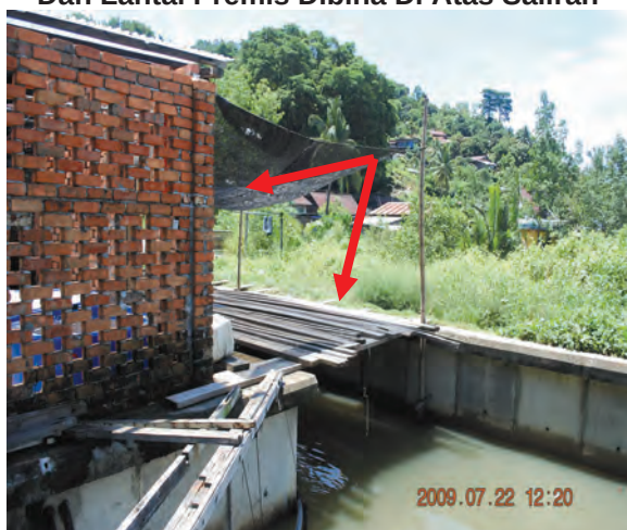
Foto 4.18 Dinding Premis Dibina Hingga Ke Saliran Dan Lantai Premis Dibina Di Atas Saliran
