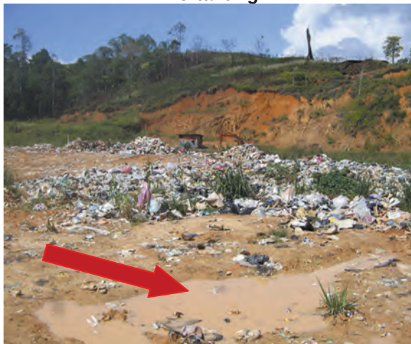
Foto 11.8 Parit Tidak Dibina Menyebabkan Air Bertakung
