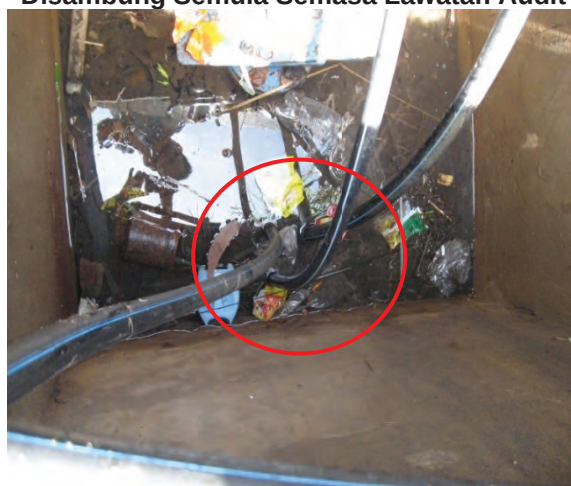
Foto 6.8 Sambungan Paip Haram Yang Disambung Semula Semasa Lawatan Audit
