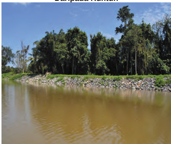
Foto 2.18 Armour Rock Revetment Bagi Menahan Tebing Sungai Daripada Runtuh
