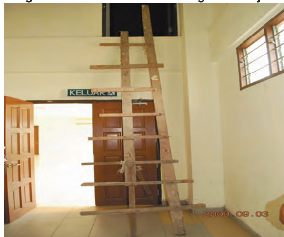
Foto 8.8 Tangga Sementara Yang Digunakan Untuk Ke Bilik Tangki Air Sejuk
