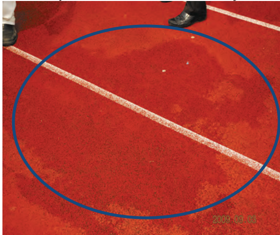
Foto 8.20 Trek Balapan Masih Basah Walaupun Selepas 30 Minit Dibasahi Air Hujan
