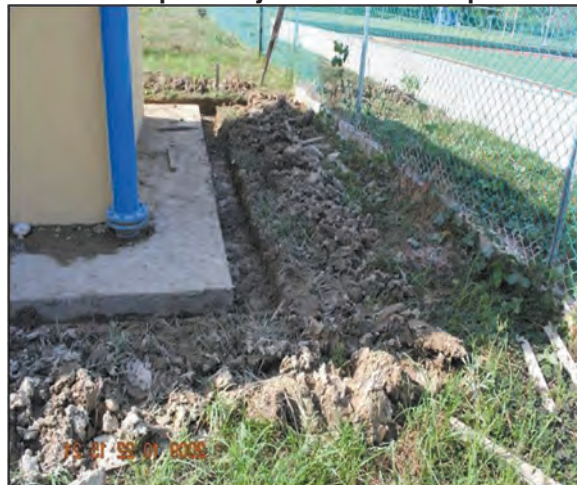
Foto 8.35 Longkang Perimeter Dibina Selepas Projek Disahkan Siap
