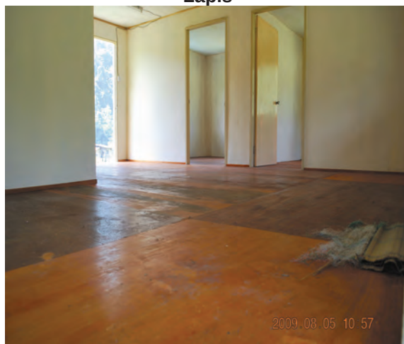
Foto 3.10 Keseluruhan Lantai Rumah Tidak Menggunakan Papan Sebaliknya Papan Lapis
