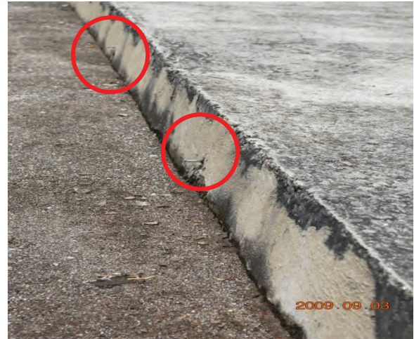
Foto 8.14 Paku Yang Masih Terpacak
