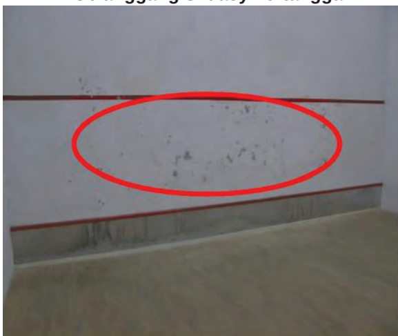
Foto 8.18 Lapisan Cat Di Dinding Gelanggang Skuasy Tertanggal
