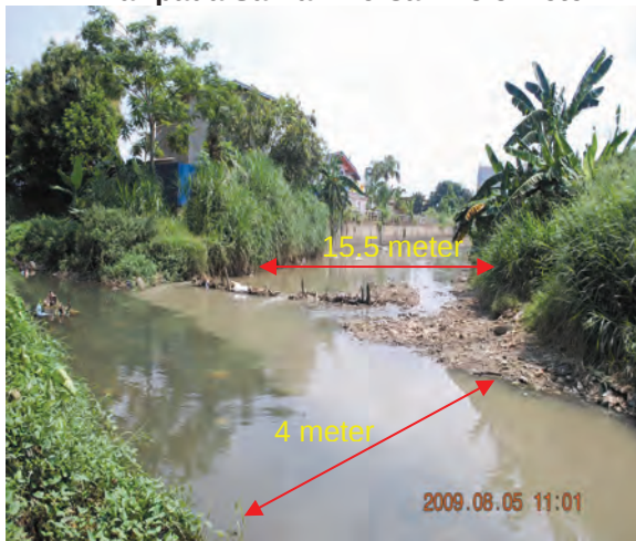
Foto 4.8 Sungai Tawau Bersaiz 4 Meter Yang Menampung Limpahan Air Daripada Saliran Bersaiz 15.5 Meter
