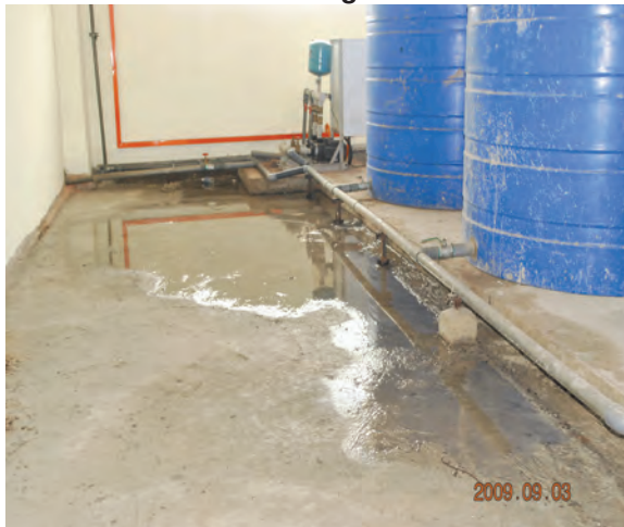
Foto 8.30 Air Melimpah Disebabkan Pengepam Air Automatik Berfungsi Secara Manual
