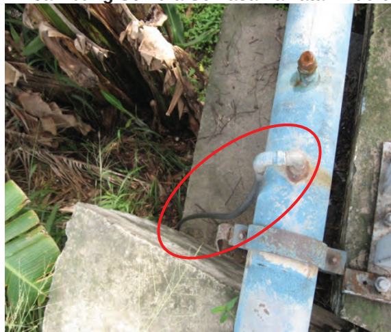
Foto 6.6 Sambungan Paip Haram Yang Disambung Semula Semasa Lawatan Audit
