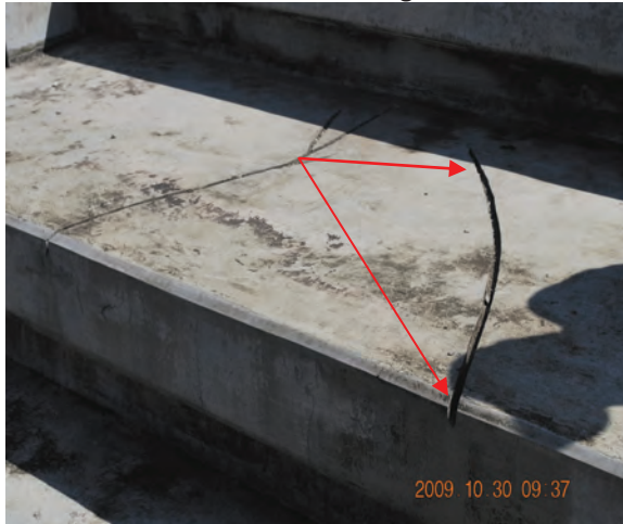
Foto 8.28 Permukaan Tempat Duduk Dibina Alur Untuk Pengaliran Air
