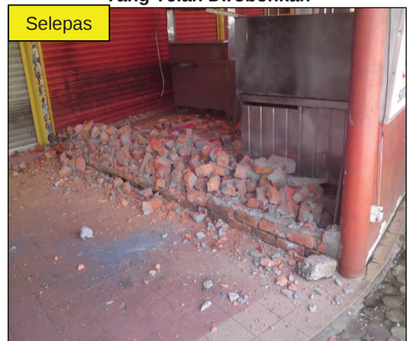
Foto 14.5 Struktur Tambahan Yang Telah Dirobohkan
