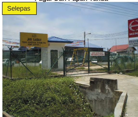
Foto 7.4 Pump Station 2 Telah Dilengkapi Pagar Dan Papan Tanda
