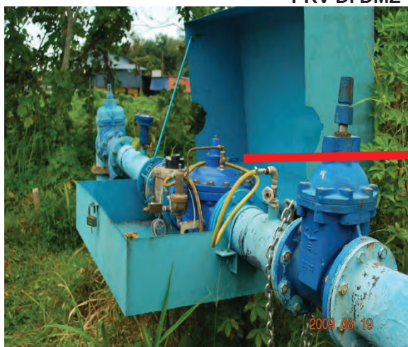
PRV Di DMZ Tidak Berfungsi
