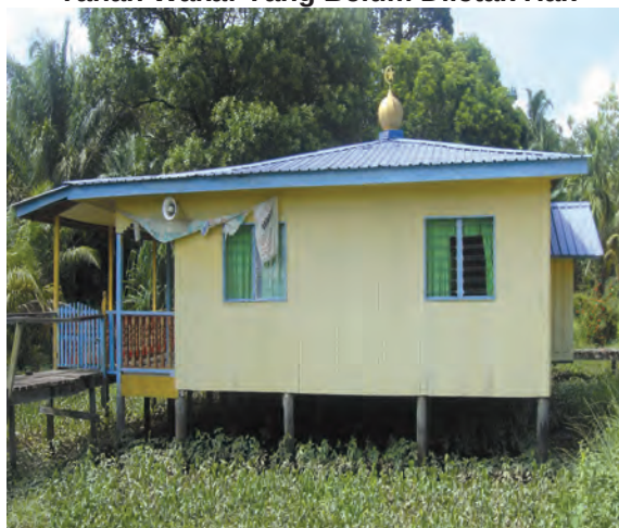
Sumber: Jabatan Audit Negara Lokasi: Masjid Muanad 2, Beluran Tarikh: 17 Ogos 2009
