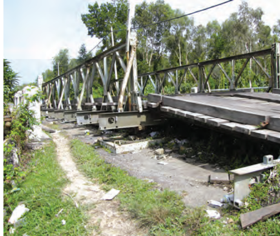
Foto 4.3 Jambatan Sementara Yang Dibina Di Kg. Tok Din, Sungai Puyu
