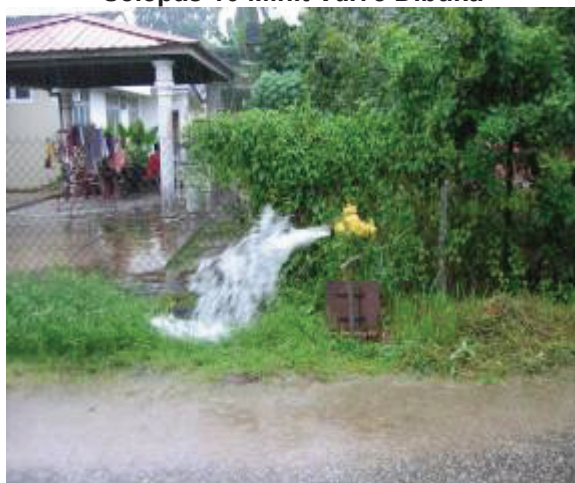
Foto 5.22 Ujian Flushing Di Jajahan Kota Bharu Selepas 10 Minit Valve Dibuka
