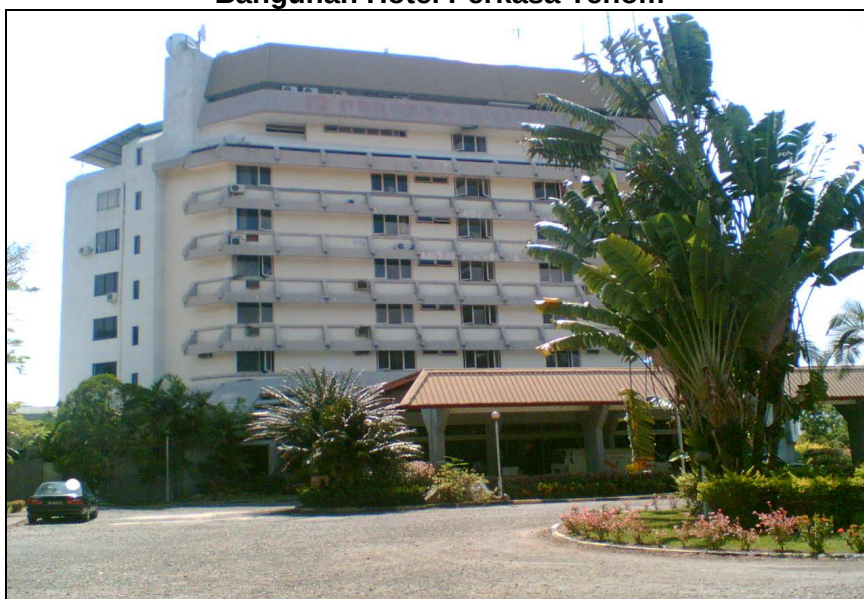
Bangunan Hotel Perkasa Tenom
