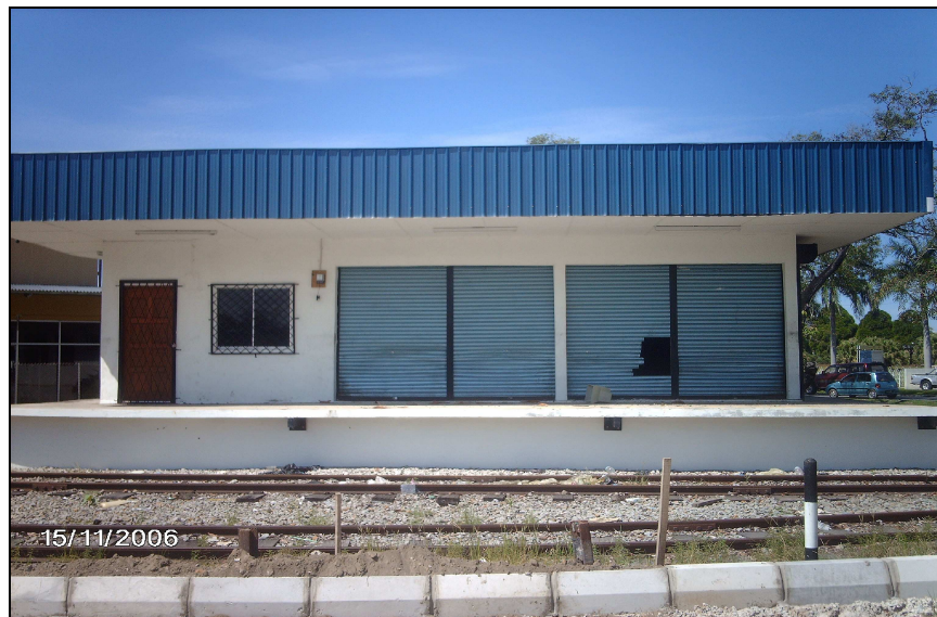
Foto 21 Bangunan Stesen KM4, Sembulan Yang Tidak Pernah Digunakan Selepas Siap Dibina Pada 6 Jun 2005
