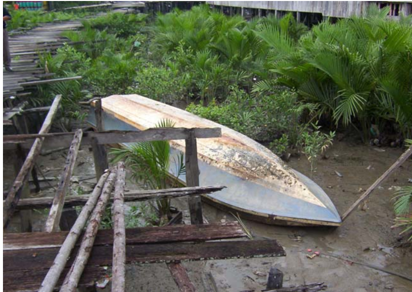
Foto 3 Perahu Yang Tidak Boleh Digunakan Lagi
