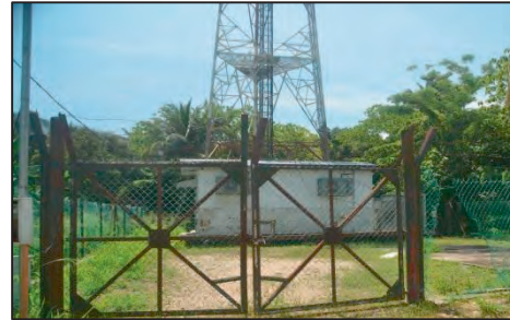
Bukit Mertajam, Pulau Pinang Struktur Menara Cherok Tok Kun -Struktur Menara Tanpa Kelulusan PBT (17.07.2019) (Sumber: Jabatan Audit Negara)
