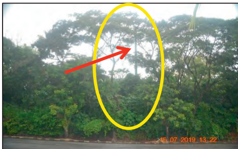
Bayan Lepas, Pulau Pinang Struktur Menara Desa Ria - Struktur Menara Sementara Tidak Beroperasi (16.07.2019) (Sumber: Jabatan Audit Negara)
