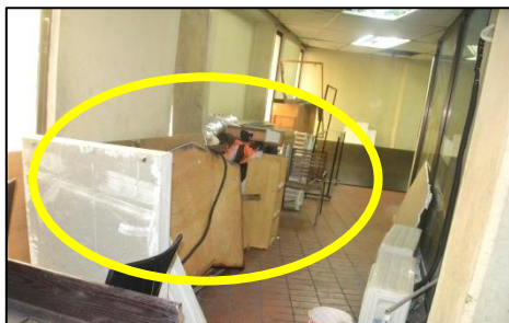
KOMTAR Fasa 1 - Barang yang Tidak Digunakan Diletakkan di Ruang Guna Sama Tingkat Tiga (3) yang Menghalang Laluan (04.07.2018)
