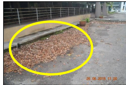
Kompleks Penjaja Bukit Minyak - Sampah yang Tidak Dibersihkan (26.06.2018)
