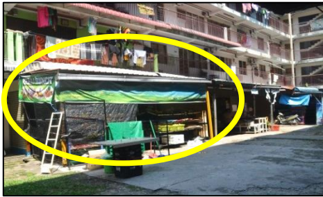
Perumahan Bukit Gedung - Tambahan Struktur Bangunan (05.07.2018)
