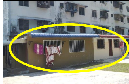
Perumahan Bukit Gedung - Tambahan Struktur Bangunan (05.07.2018)
