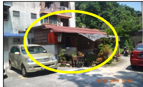
Perumahan Bukit Gedung - Tambahan Struktur Bangunan (05.07.2018)
