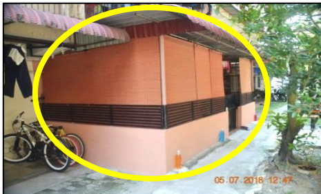
Perumahan Bukit Gedung - Tambahan Struktur Bangunan (05.07.2018)
