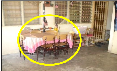
Perumahan Kristal Idaman - Perabot Diletakkan di Ruang Guna Sama yang Menghalang Laluan (04.07.2018)
