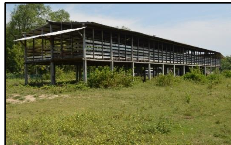
Bersebelahan Lot 2598, Mukim 4, Seberang Perai Utara - Kandang Ternakan Beroperasi di Atas Tapak yang Ditolak (05.07.2018)
