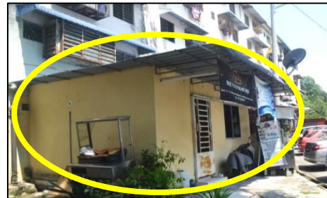
Perumahan Bukit Gedung - Tambahan Struktur Bangunan (05.07.2018)
