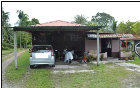
Sebahagian Lot 578 dan 579 (Plot 3A), Mukim 16, Seberang Perai Utara - Bangunan Kediaman Diduduki oleh Kakak Kandung (11.07.2018)
