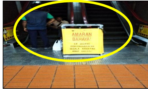
KOMTAR Fasa 1 - Penyenggaraan Escalator yang Sedang Dijalankan (04.07.2018)
