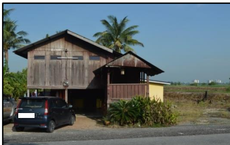
Bersebelahan Lot 1529, Mukim 7, Seberang Perai Utara - Bangunan Kediaman Telah Didirikan di Atas Tapak yang Ditolak (12.07.2018)
