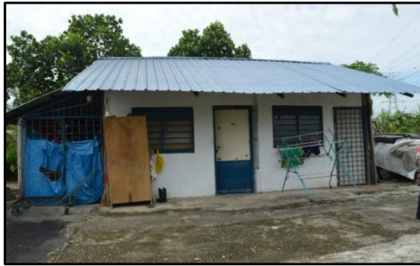
Bersebelahan Lot 2517 (Plot 42), Mukim 16, Seberang Perai Utara - Bangunan Kediaman Telah Didirikan di Tapak yang Ditolak (11.07.2018)
