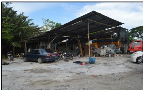
Bersebelahan Lot 3579, Mukim 16, Seberang Perai Utara - Bangunan Bengkel Beroperasi di Atas Tapak yang Ditolak (11.07.2018)
