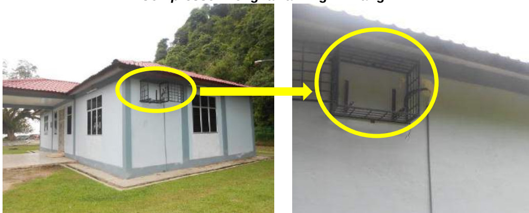
Gambar 4.11 Compressor Penghawa Dingin Hilang
