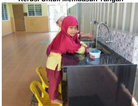
Gambar 2.16 Kedudukan Singki Yang Tinggi Di Mana Murid Terpaksa Menggunakan Kerusi Untuk Membasuh Tangan
