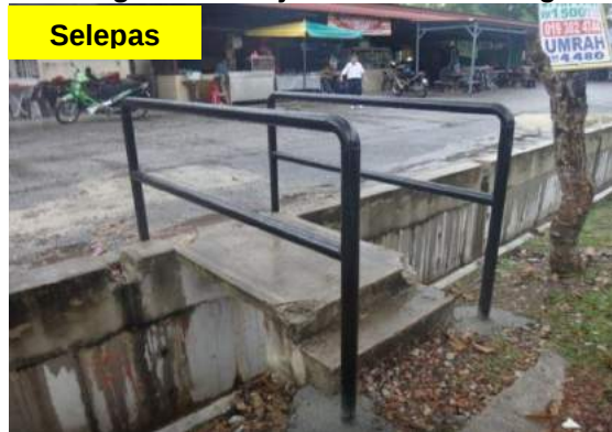
Gambar 4.4 Railing Laluan Pejalan Kaki Telah Diganti
