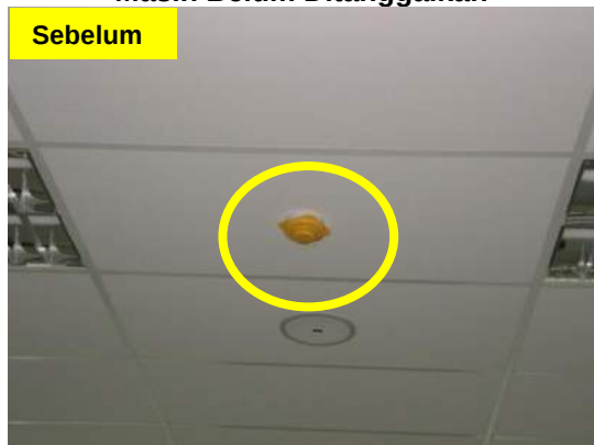
Gambar 1.7 Penutup Alat Pengesan Kebakaran Masih Belum Ditanggalkan
