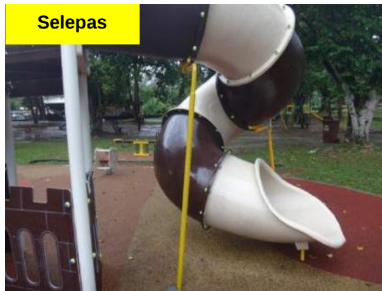
Gambar 4.6 Tiang Penyokong Papan Gelongsor Diganti
