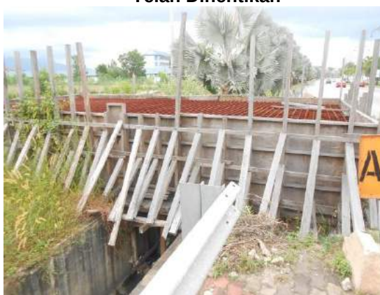
Gambar 4.16 Kerja Pembinaan Asas Pintu Gerbang Telah Dihentikan
