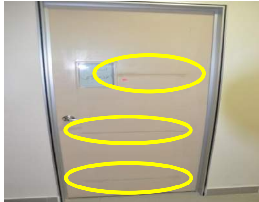
Gambar 1.12 Retakan Dan Rekahan Pada Pintu
