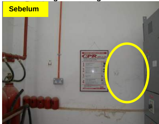
Gambar 1.5 Lukisan Litar Skematik Tidak Dilekatkan Di Bahagian Dinding Bilik Suis
