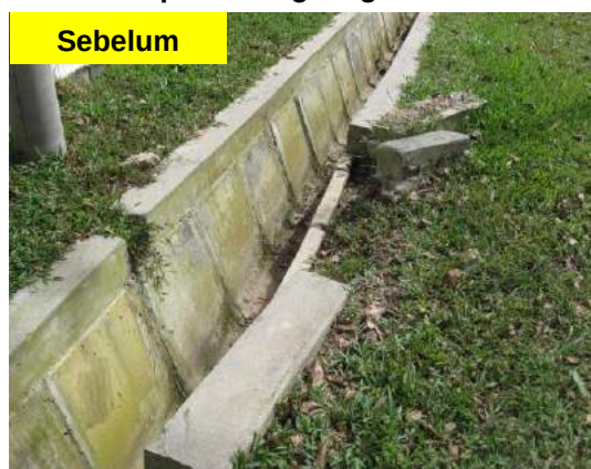
Gambar 4.1 Lepaan Longkang Pecah
