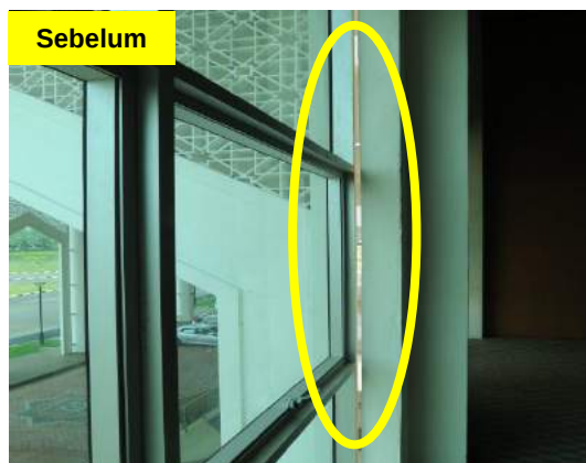
Gambar 1.1 Renggangannya Antara Dinding Struktur Utama Dengan Kerangka Kaca
