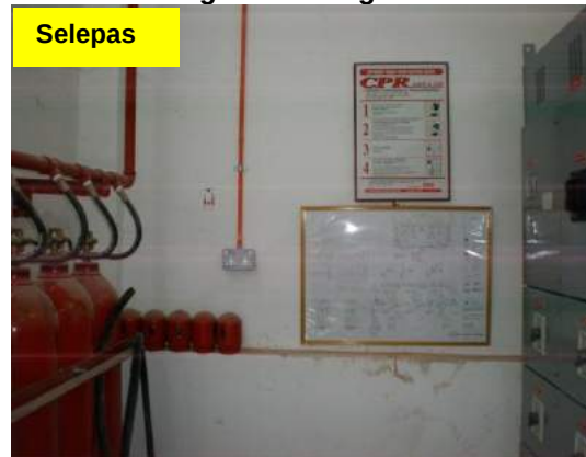
Gambar 1.6 Lukisan Litar Skematik Dilekatkan Di Bahagian Dinding Bilik Suis
