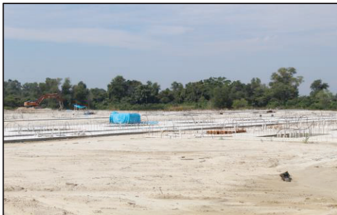
Projek PKPPNP Perak Tengah - Pembinaan Fasa 2 - Tapak Rumah Teres Setingkat (14.09.2023) Sumber: Jabatan Audit Negara
