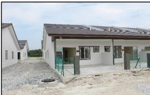
Projek PKPPNP Batang Padang - Rumah Siap Dibina (13.09.2023) Sumber: Jabatan Audit Negara
