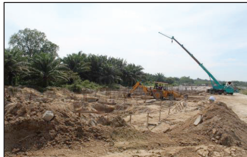
Projek PKPPNP Perak Tengah - Pembinaan Fasa 2 - Tapak Kedai Komersial (14.09.2023) Sumber: Jabatan Audit Negara
