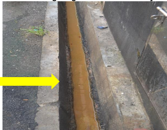
Gambar 3.21 Perangkap Minyak Tidak Disenggara Menyebabkan Longkang Kotor Dan Berminyak
