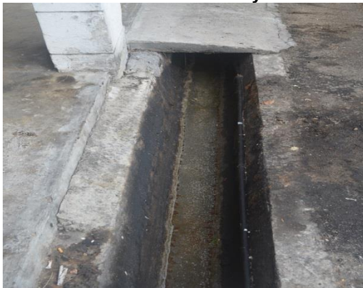
Gambar 3.23 Longkang Bertakung Dengan Sisa Makanan Dan Minyak
