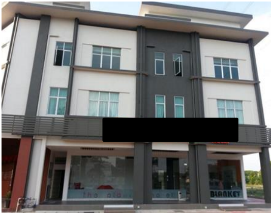
Gambar 3.4 Permohonan Lesen Tidak Diluluskan Kerana Mempunyai Binaan Tanpa Kebenaran
