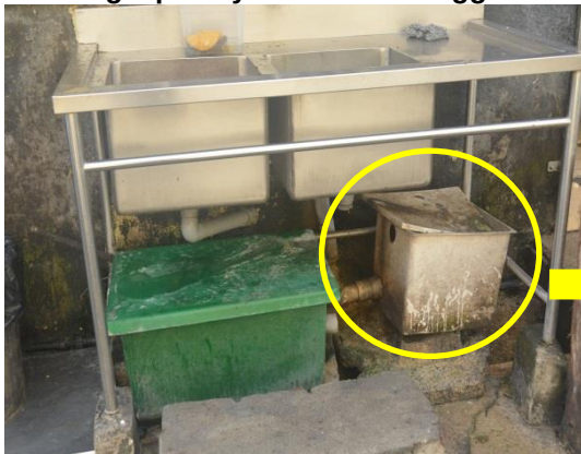
Gambar 3.21 Perangkap Minyak Tidak Disenggara Menyebabkan Longkang Kotor Dan Berminyak
