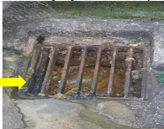
Gambar 3.20 Perangkap Minyak Tidak Disenggara Menyebabkan Longkang Kotor Dan Berminyak
