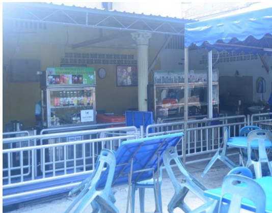
Gambar 3.8 Permohonan Lesen Tidak Diluluskan Kerana Mempunyai Binaan Tanpa Kebenaran
