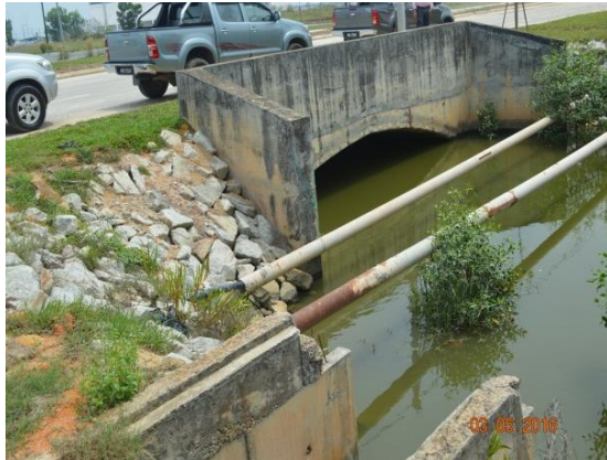
Gambar 4.1 Salah Satu Outfall Structure Menggunakan Armour Rock Dibina Di Luar Tapak Kontrak
