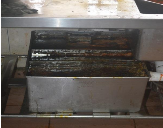
Gambar 3.18 Perangkap Minyak Tidak Disenggara
