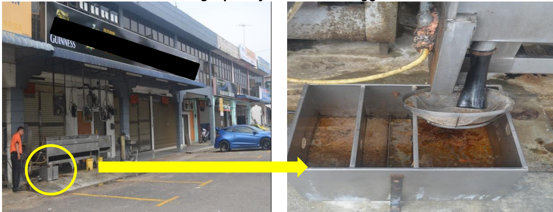
Gambar 3.22 Perangkap Minyak Tidak Disenggara
