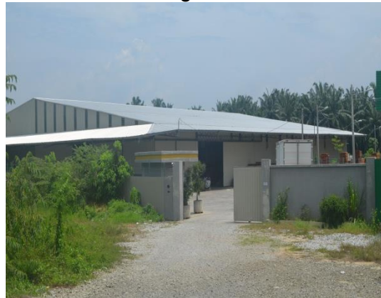
Gambar 3.7 Permohonan Lesen Tidak Diluluskan Kerana Tidak Mempunyai Pelan Kebenaran Merancang Dan Pelan Bangunan
