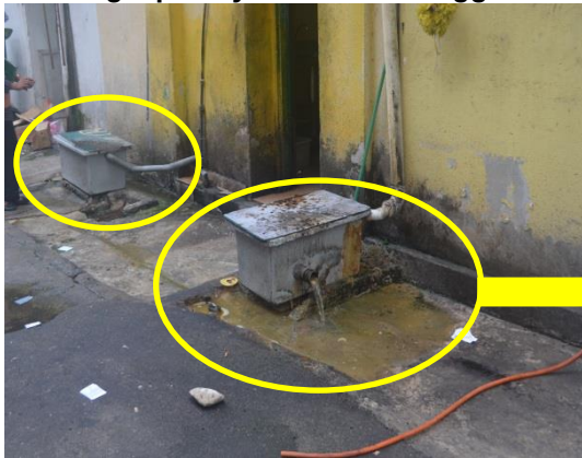
Gambar 3.20 Perangkap Minyak Tidak Disenggara Menyebabkan Longkang Kotor Dan Berminyak
