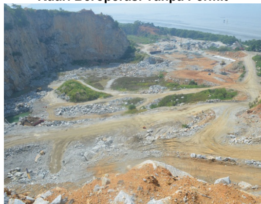
Gambar 2.6 Kuari Beroperasi Tanpa Permit
