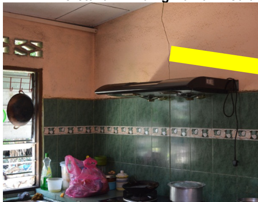
Gambar 2.11 Keretakan Dinding Rumah Kediaman Akibat Dari Aktiviti Letupan Batu
