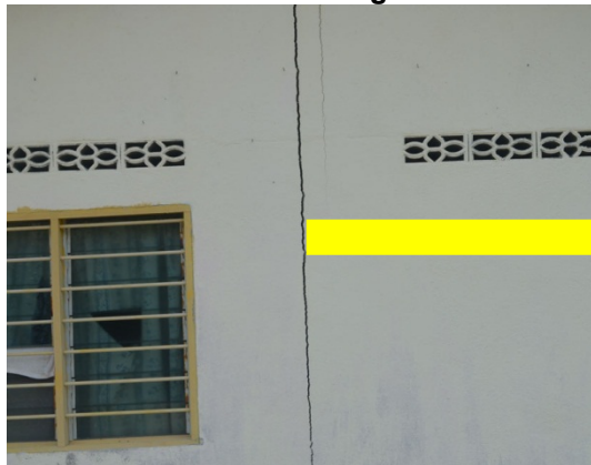
Gambar 2.10 Keretakan Dinding Rumah Kediaman Akibat Dari Aktiviti Letupan Batu
