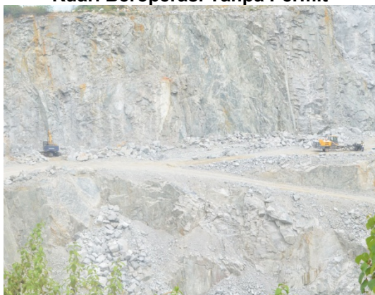
Gambar 2.7 Kuari Beroperasi Tanpa Permit
