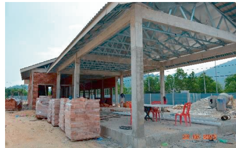
Kuarters Pekerja dan Ruang Generator -Kerja Binaan Asas Bangunan Sedang Dilaksanakan (22.06.2023) (Sumber: Jabatan Audit Negara)
