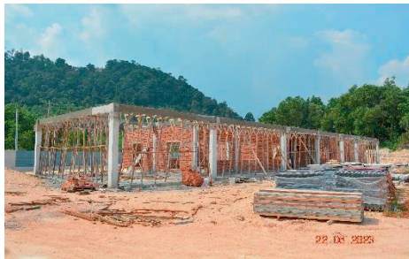
Pejabat Pentadbiran, Kuarters Kakitangan, Surau, Stor dan Harvest Station -Kerja Binaan Asas Bangunan Sedang Dilaksanakan (22.06.2023) (Sumber: Jabatan Audit Negara)
