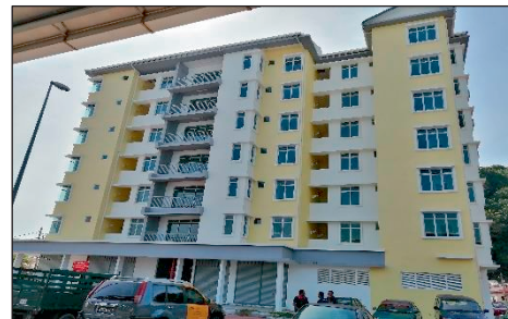
Projek PSPN Sg. Pinang Besar (Fasa 2) - Bangunan Apartmen Hampir Siap (14.02.2023) (Sumber: Jabatan Audit Negara)
