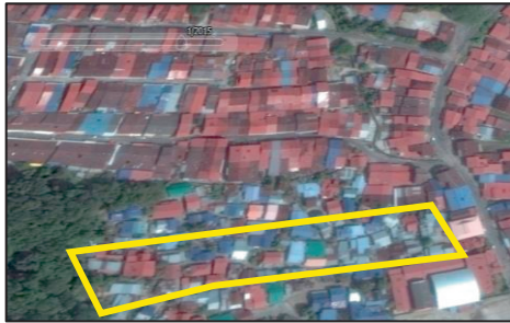
Projek PSPN Sg. Pinang Besar (Fasa 3) - Keadaan Kawasan Sebelum Pembinaan (29.1.2015) (Sumber: Google Earth)
