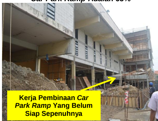
Gambar 3.5 Peratusan Siap Kerja Bagi Construction Of Car Park Ramp Adalah 65%
