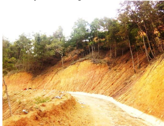
Gambar 2.32 Hydroseeding Belum Dibuat
