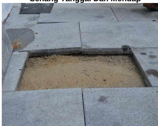
Gambar 3.24 Kaedah Pemasangan Asal Yang Tidak Sempurna Menyebabkan Interlocking Block Senang Tanggal Dan Mendap
