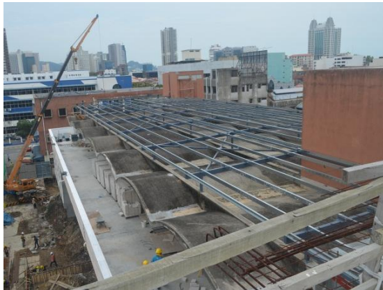
Gambar 3.9 Peratusan Siap Kerja Bagi Roof Construction Adalah 85%
