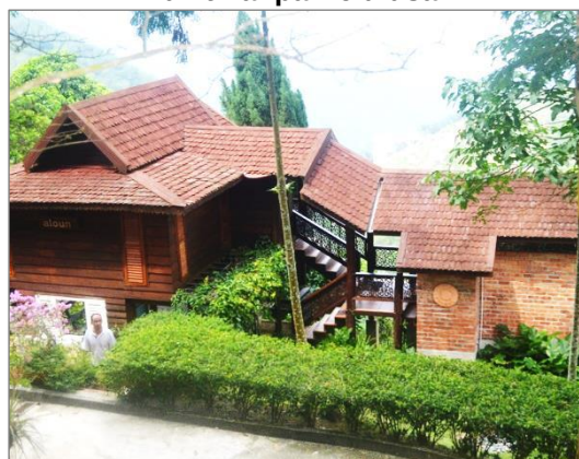
Gambar 2.13 Pembinaan Chalet Di Kawasan Tanah Bukit Tanpa Kelulusan
