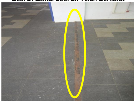
Gambar 3.25 Besi Di Lantai Lobi Lif Telah Berkarat
