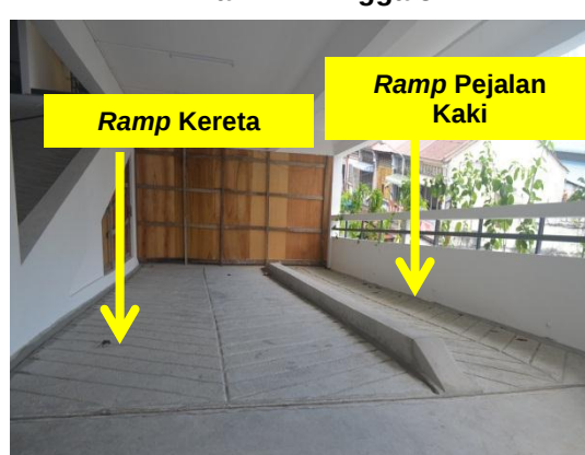
Gambar 3.31 Kedudukan Yang Mengelirukan Di Antara Ramp Kereta Dan Ramp Pejalan Kaki Di Parkir 2 Hingga 5
