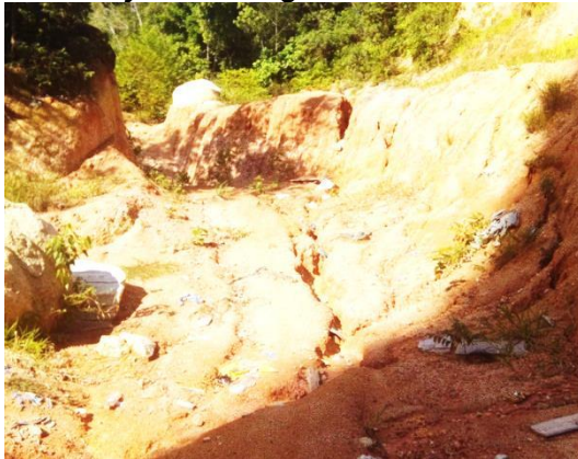
Gambar 2.29 Hydroseeding Tidak Dibuat
