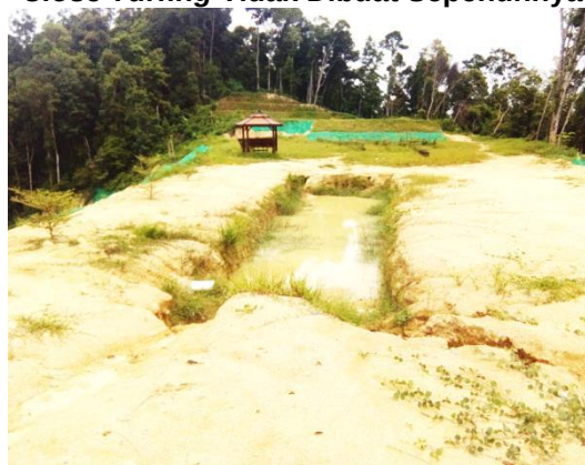
Gambar 2.26 Close Turfing Tidak Dibuat Sepenuhnya
