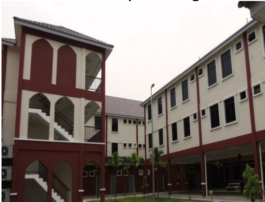
Gambar 1.24 Blok Asrama Siap Tidak Digunakan
