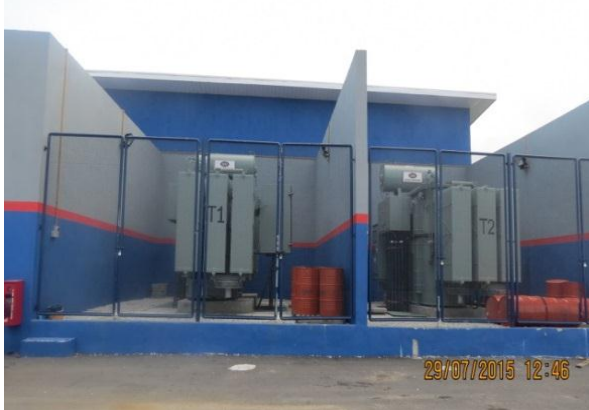
Gambar 4.1 Mesin-Mesin Dan Peralatan Telah Dipasang
