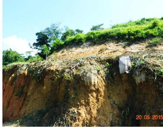
Gambar 2.28 Hydroseeding Tidak Dibuat Sepenuhnya
