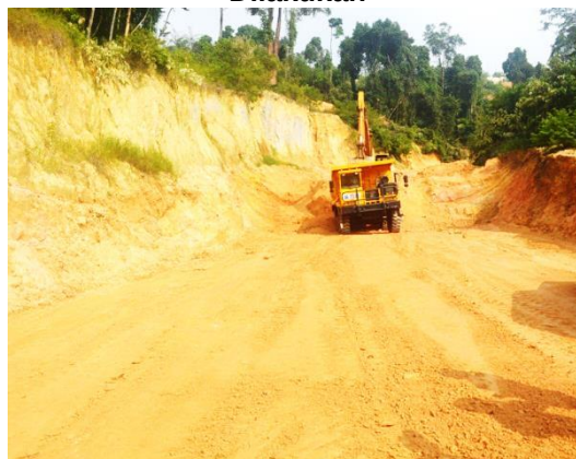
Gambar 2.24 Hydroseeding Di Cerun Bukit Tidak Dilakukan
