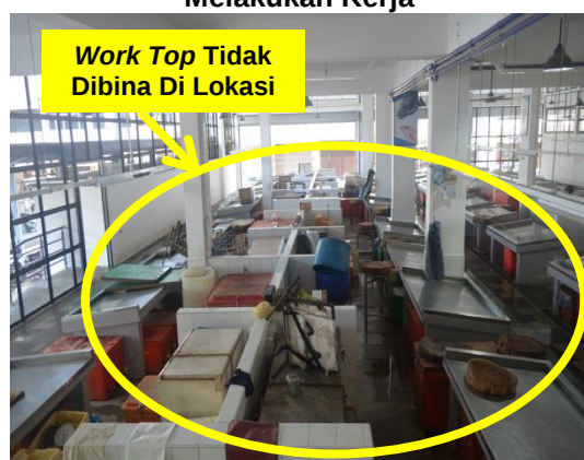
Gambar 3.13 44 Buah Work Top Tidak Dibina Di Lokasi Menyebabkan Kesukaran Peniaga Melakukan Kerja
