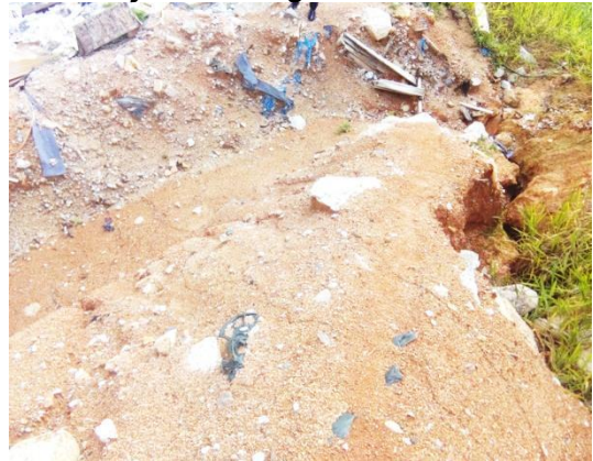
Gambar 2.30 Hydroseeding Tidak Dibuat
