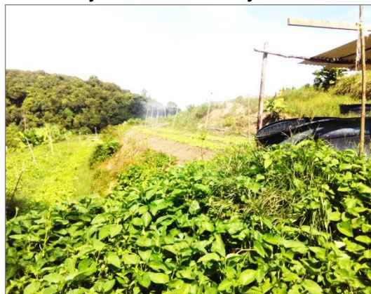
Gambar 2.22 Kerja Tanah Masih Dijalankan
