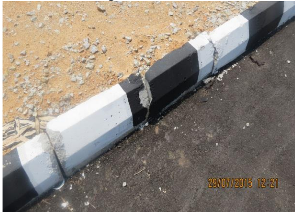
Gambar 4.7 Kerosakan Bangunan Akibat Kerja-Kerja Memasang Mesin Dan Peralatan
