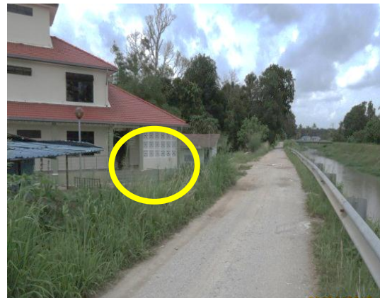
Gambar 1.36 Pintu Pagar Belakang Surau Melalui Jalan Tali Air
