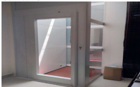
Pejabat MPN - Pemasangan lif (29.02.2024) (Sumber: Jabatan Audit Negara)
