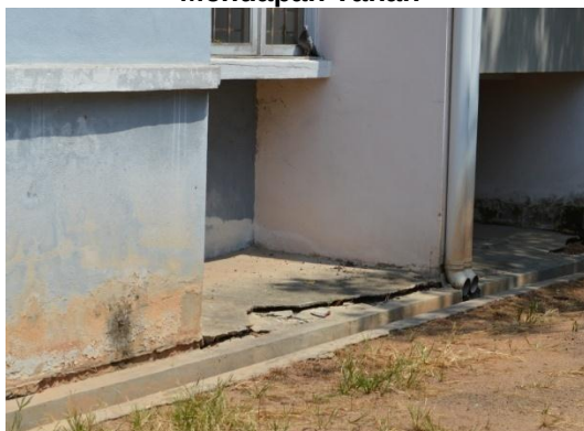
Gambar 4.9 Mendapan Tanah
