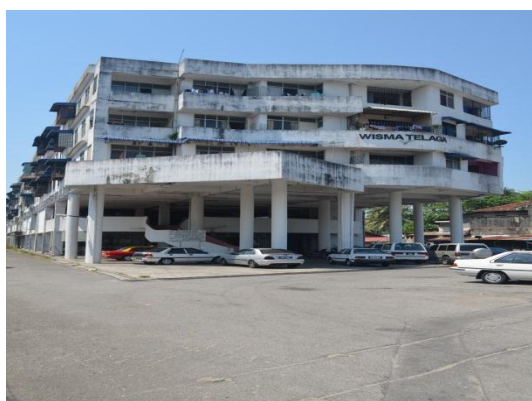
Gambar 2.6 Bangunan Skim Telaga Air Yang Menghadapi Masalah Partial CFO
