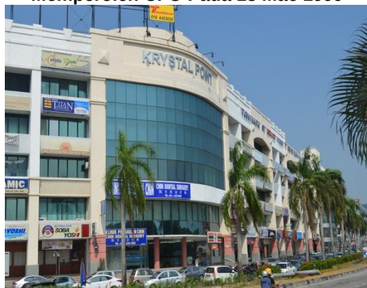
Gambar 2.12 Bangunan Skim Krystal Point Yang Memperoleh CFO Pada 13 Mac 1999
