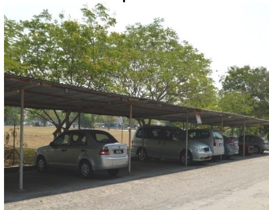
Gambar 4.4 Binaan Tempat Letak Kereta
