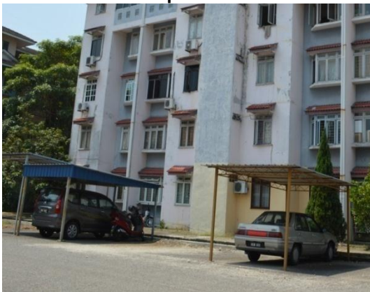
Gambar 4.3 Binaan Tempat Letak Kereta
