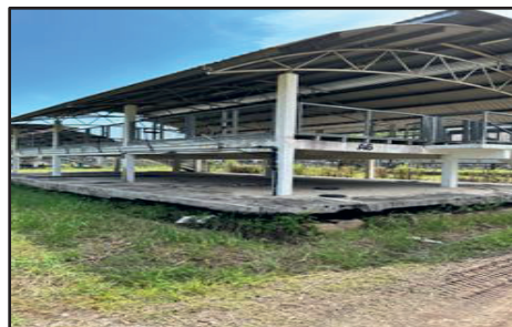
APU Zon A – A6, Projek Agropolitan Besut Setiu - Pemendapan Tanah Berlaku di Sekeliling Struktur APU (24.05.2023) (Sumber: Jabatan Audit Negara)
