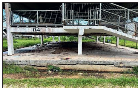
APU Zon B – B4 dan B6, Projek Agropolitan Besut Setiu - Pemendapan Tanah di Bahagian Lantai bawah APU (24.05.2023) (Sumber: Jabatan Audit Negara)
