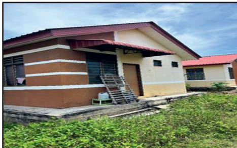
Kuarters Projek Agropolitan Besut Setiu - Pemendapan Tanah di Sekeliling Kawasan Rumah (24.05.2023) (Sumber: Jabatan Audit Negara)
