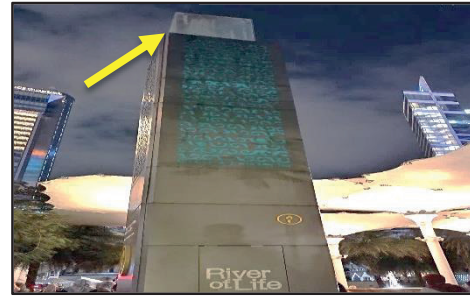
Guiding Light, Masjid Jamek - Guiding Light yang Tidak Menyala (24.02.2023) (Sumber: Jabatan Audit Negara)
