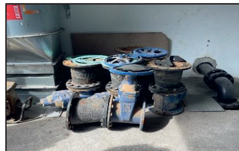
Stesen Pam KLR 146 - Fittings Pipe Bagi Enam Unit Raw Sewage Pump Lama yang Tidak Boleh Digunakan (21.03.2023) (Sumber: Jabatan Audit Negara)
