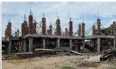
BBP Teluk Intan, Perak - Bangunan BBP Dalam Pembinaan (23.01.2024)
