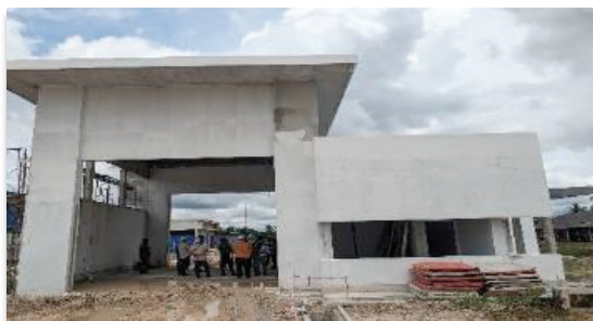
BBP Palong 6, Negeri Sembilan - Bangunan BBP Dalam Pembinaan (23.01.2024)
