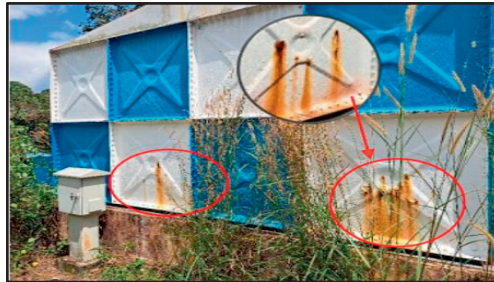
Rumah Pam Ulu Yoh, Daerah Tampin - Kesan Pengaliran Air Keluar dari Tangki Jenis Pressed Steel (PS) (08.02.2023) (Sumber: Jabatan Audit Negara)
