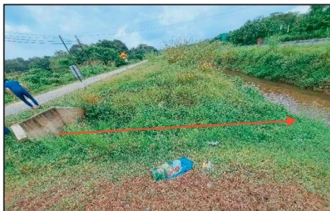
Lorong Haji Saleh 2, Kampung Sawah Sunggal, Port Dickson - Saliran Keluar Pintu Flap Gate Dipenuhi Dengan Semak (03.03.2023) (Sumber: Jabatan Audit Negara)
