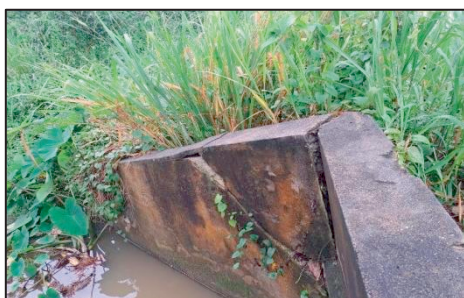
Kampung Si Rusa, Port Dickson - Struktur Wing Wall yang Mengalami Keretakan (03.03.2023) (Sumber: Jabatan Audit Negara)
