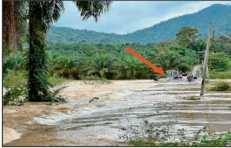
Jambatan Bailey, Kampung Bemban - Kejadian Banjir Disebabkan Limpahan Air Sungai Triang (02.03.2023) (Sumber: Jabatan Audit Negara)
