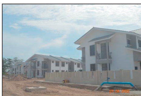
TIRCC, Kuala Terengganu - Projek Dalam Pembinaan (21.06.2022) (Sumber: Jabatan Audit Negara)
