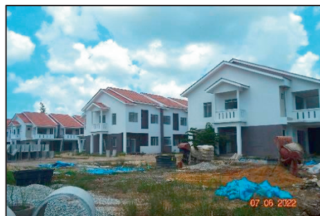
Projek Pembangunan di Muara Sungai Marang - Projek Dalam Pelaksanaan (07.06.2022) (Sumber: Jabatan Audit Negara)
