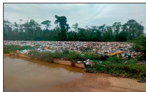
TPSP Batu 22 - Keadaan Semasa di Tapak yang Telah Melebihi Jangka Hayat dan Kapasiti Penggunaan (28.09.2022) (Sumber: Jabatan Audit Negara)
