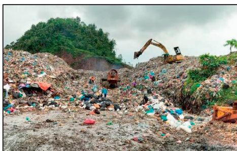
TPSP Sungai Ikan - Keadaan di Tapak yang Telah Melebihi Jangka Hayat (12.09.2022) (Sumber: Jabatan Audit Negara)
