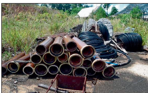
Pulau Bayas, Tasik Kenyir - Material on Site (Paip dan Kabel) Terbiar (22.05.2023) (Sumber: Jabatan Audit Negara)
