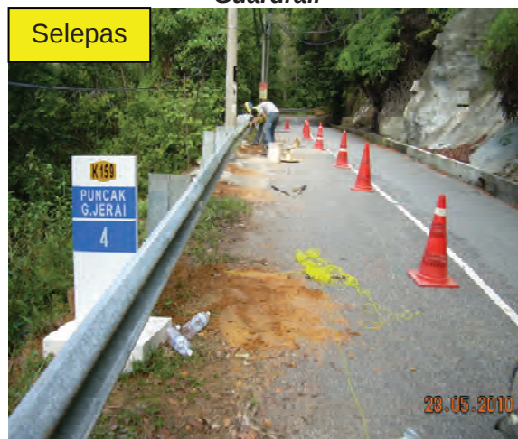
Foto 3.34 Jalan Bercerun Tinggi Telah Dipasang Guardrail
