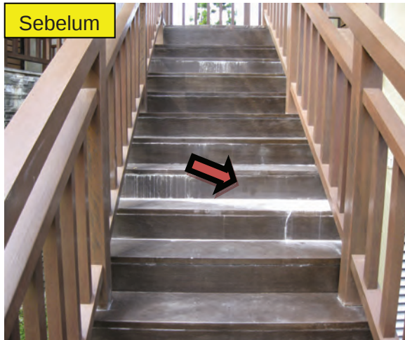
Foto 8.8 Bleeding Dari Bahan Platform Tangga
