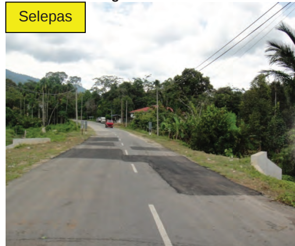
Foto 3.26 Permukaan Jalan Yang Telah Dibaiki
