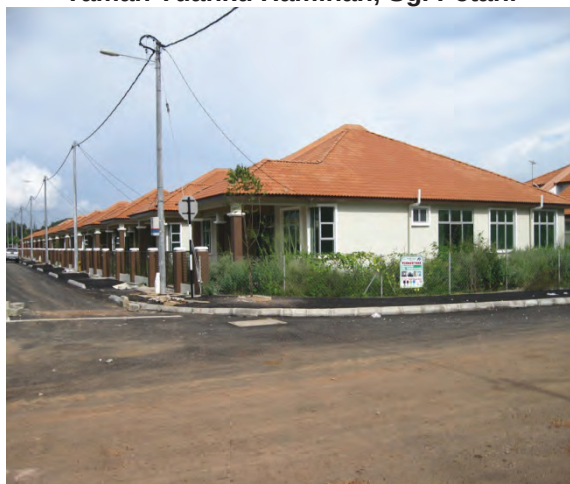
Foto 12.2 Projek Pembangunan Taman Tuanku Haminah, Sg. Petani
