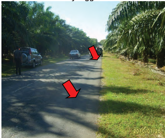
Foto 3.21 Jalan Mendap Semula Selepas Kerja Penyenggaraan
