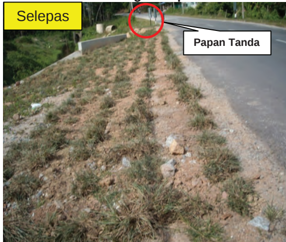
Foto 3.25 Penanaman Rumput Di Cerun Dan Pemasangan Papan Tanda
