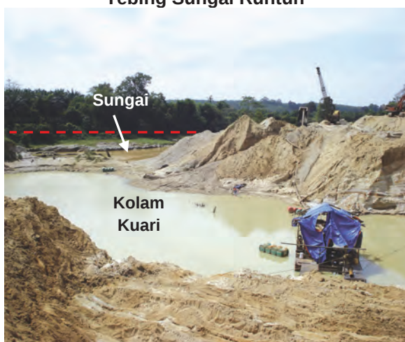
Foto 7.7 Tebing Sungai Runtuh
