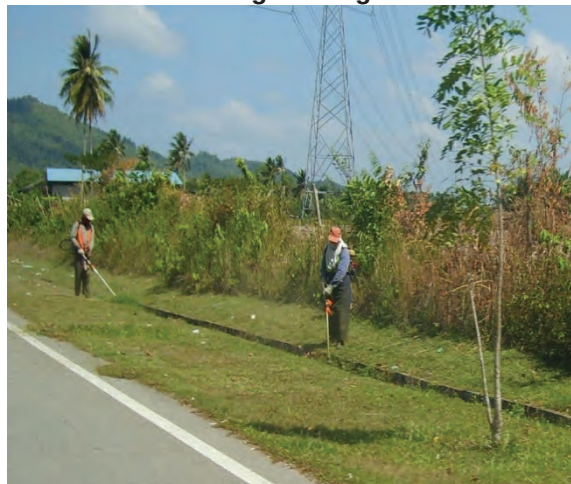
Foto 3.12 Bahu Jalan Yang Sedang Dibersihkan
