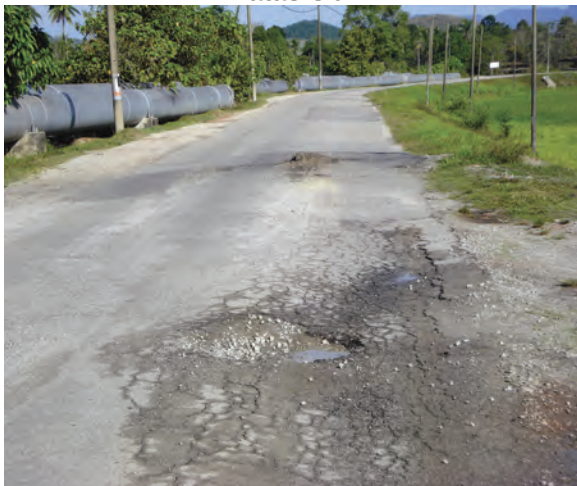
Foto 7.17 Permukaan Jalan Berlopak Dan Pembentukan 'Batas Ubi'
