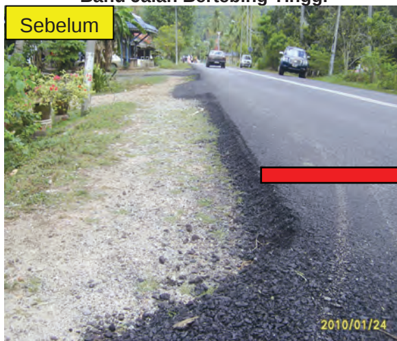
Foto 3.15 Bahu Jalan Bertebing Tinggi
