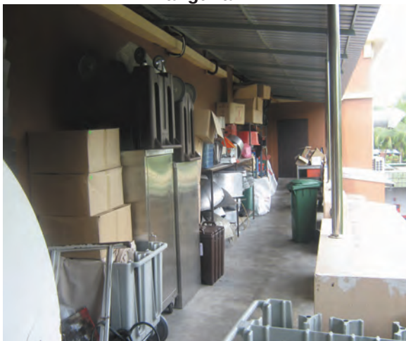
Foto 11.13 Peralatan Dapur Diletakkan Di Koridor Bangunan
