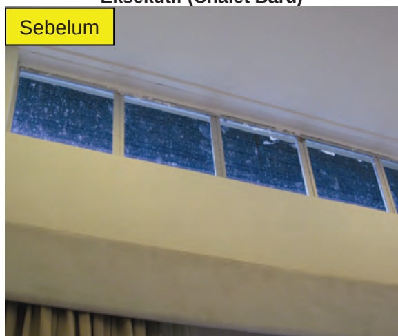
Foto 8.2 Airwell Yang Dipenuhi Fungus Di Bilik Eksekutif (Chalet Baru)
