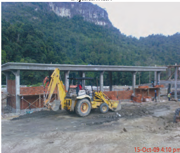
Foto 9.16 Kerja Pembinaan Incinerator Sedang Dijalankan
