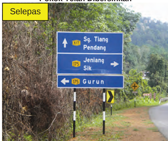
Foto 3.9 Papan Tanda Yang Terlindung Dengan Dahan Pokok Telah Dibersihkan
