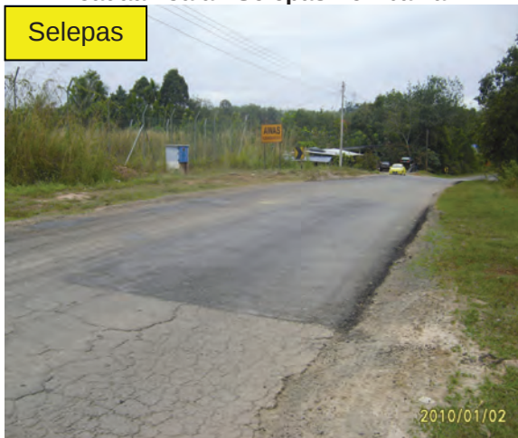
Foto 3.3 Keadaan Jalan Selepas Pembaikan
