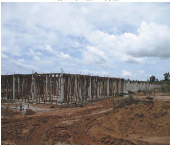
Foto 12.3 Projek Pembinaan Taman Perumahan Dan Rumah Kedai
