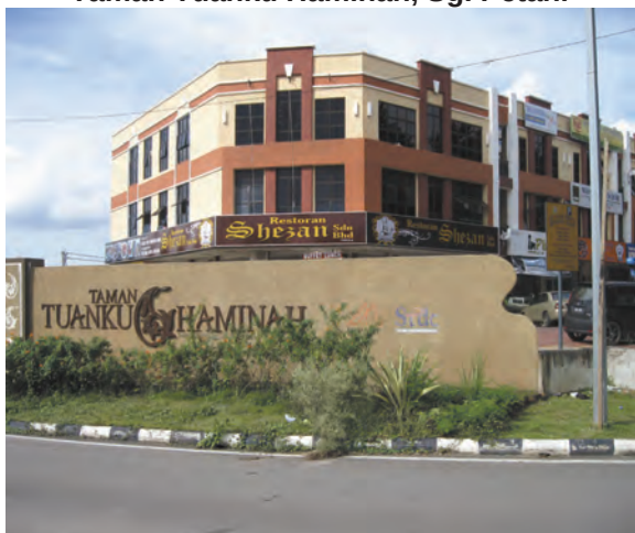
Foto 12.1 Projek Pembangunan Taman Tuanku Haminah, Sg. Petani
