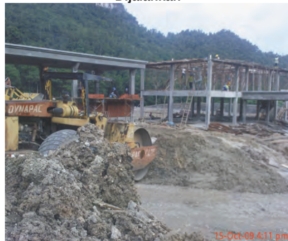
Foto 9.17 Kerja Pembinaan Incinerator Sedang Dijalankan
