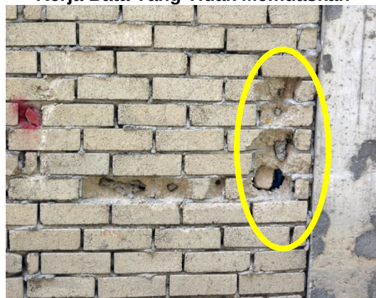
Gambar 13.5 Kerja Bata Yang Tidak Memuaskan
