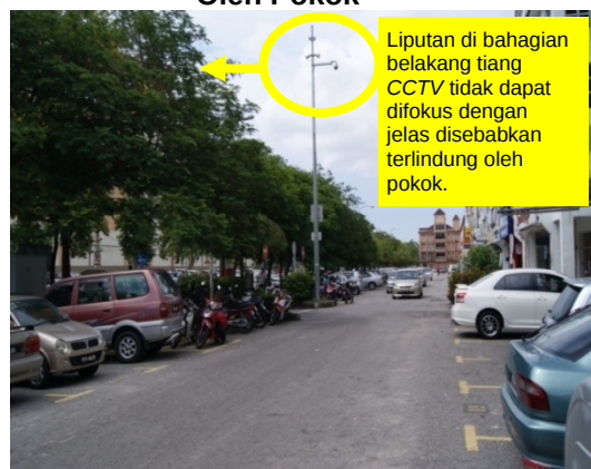
Gambar 6.4 Kedudukan Tiang CCTV Terlindung Oleh Pokok
