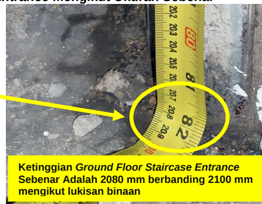
Gambar 13.11 Ketinggian Groundfloor Staircase Entrance Mengikut Ukuran Sebenar
