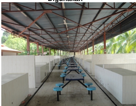
Gambar 5.5 Kompleks Makanan Yang Tidak Digunakan
