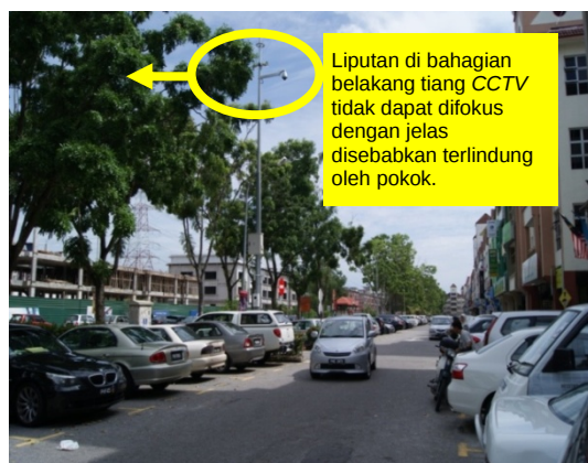
Gambar 6.5 Kedudukan Tiang CCTV Terlindung Oleh Pokok
