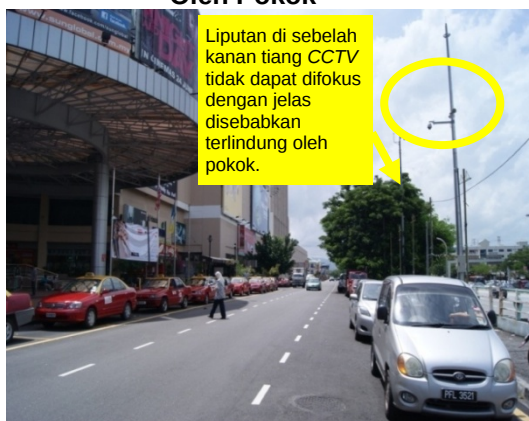
Gambar 6.3 Kedudukan Tiang CCTV Terlindung Oleh Pokok
