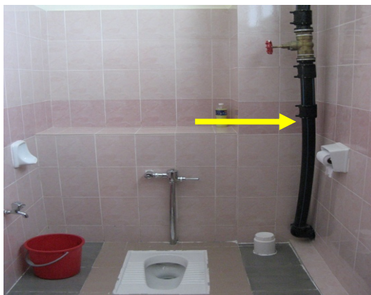
Gambar 2.14 Kedudukan Paip Air Yang Berada Di Luar Dinding Bangunan
