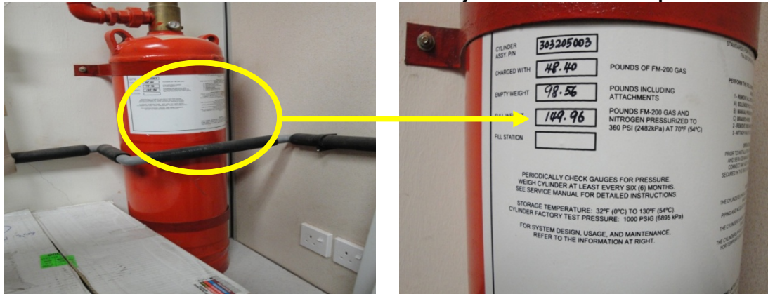
Gambar 3.5 Tiada Bukti Alat Pemadam Kebakaran Diuji Dan Tiada Tarikh Luput
