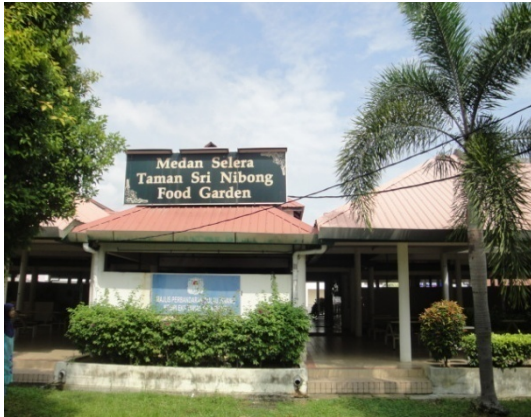
Gambar 5.21 Kompleks Makanan Yang Tidak Digunakan
