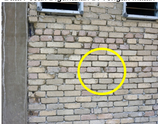
Gambar 13.4 Bata Pecah Digunakan Di Tengah Ikatan
