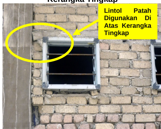
Gambar 13.7 Lintol Patah Digunakan Di Atas Kerangka Tingkap
