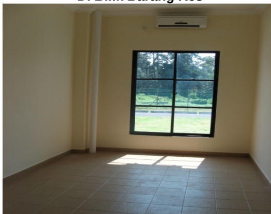
Gambar 2.10 Penghadang/ Grill Yang Tidak Dipasang Di Bilik Barang Kes
