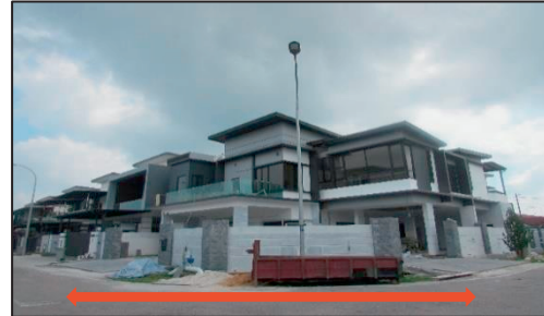
Laluan Pejalan Kaki Tidak Disediakan di Projek Perumahan Pontian (20.06.2023) (Sumber: Jabatan Audit Negara)
