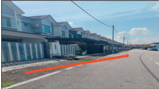
Laluan Pejalan Kaki Tidak Disediakan di Projek Perumahan Pontian (19.06.2023) (Sumber: Jabatan Audit Negara)
