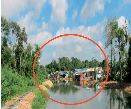
Pembinaan Rumah Di Rizab Sungai Taman Rinting, Johor Bahru (21.11.2022) (Sumber: Jabatan Audit Negara)
