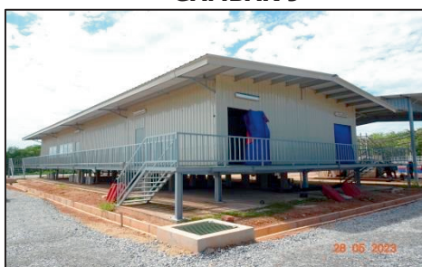
Tok Uban, Pasir Mas - Bangunan fasiliti elektrik yang mengumpulkan tenaga untuk disalurkan ke LILO melalui kabel penyambung (28.05.2023) (Sumber: Jabatan Audit Negara)
