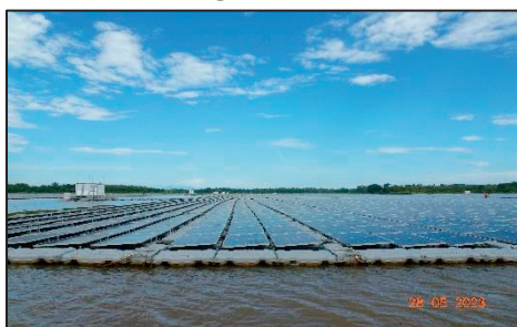
Tasik Danau Tok Uban, Pasir Mas - Panel solar terapung yang telah siap dipasang (28.05.2023) (Sumber: Jabatan Audit Negara)
